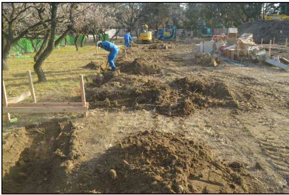
写真2 現場状況／北から
