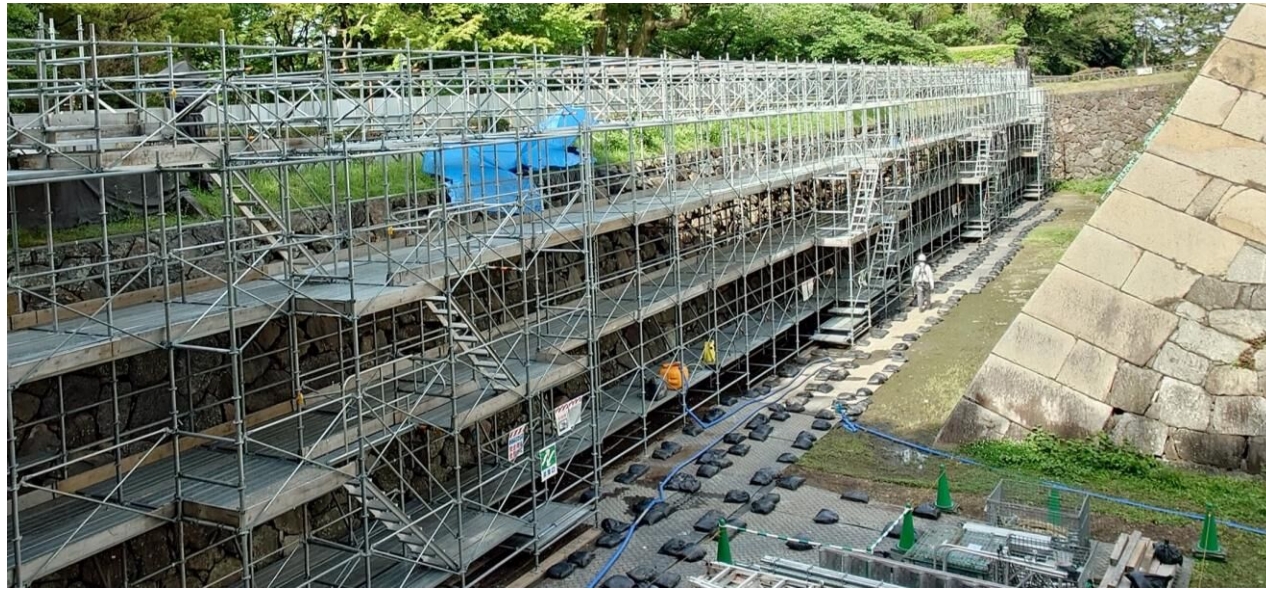
足場を設置し保存対策を工事を実施した状態
