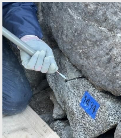
補修材の注入
