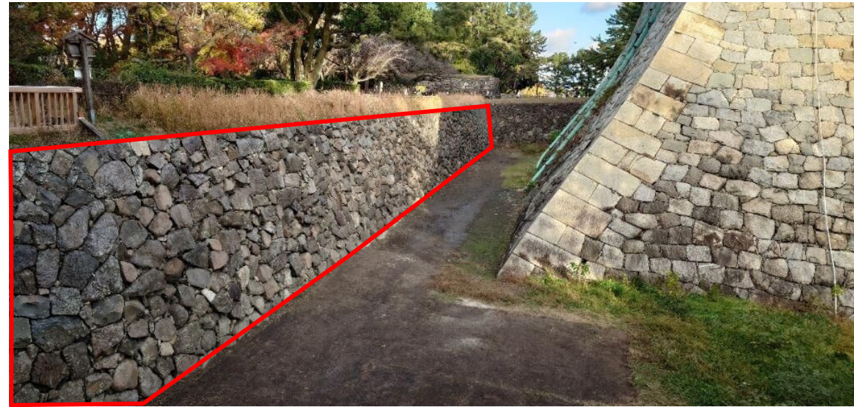
天守台北側石垣対面の石垣
