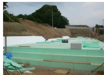
株式会社ジオテックHP「発泡スチロールを用いた超軽量盛土工」より
