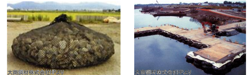
図2-3-9 ポトルユニット(単体)とポトルユニットによる埋め立て構台の例
