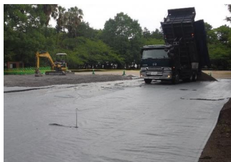
平成30年6月 特別史跡名古屋城跡の現状変更「石垣調査のための仮設事務所等工事」より
