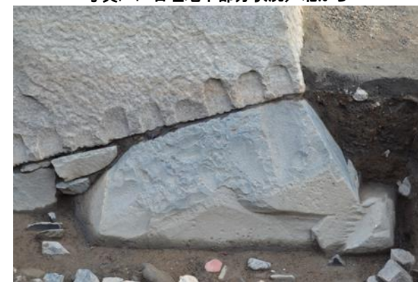
写真F-3 石垣地下部分状況/北から 角石の上半を加工している様子。
