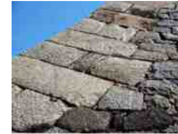
図05 U060隅角石に見られる割れ.jpg
