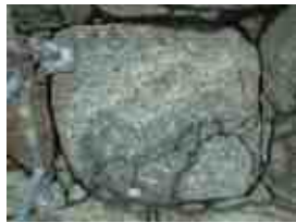
石材調査状況
