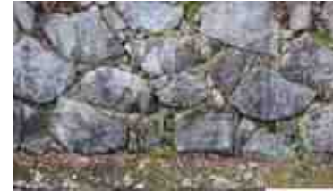
図03 U061_間詰めの状況.jpg
