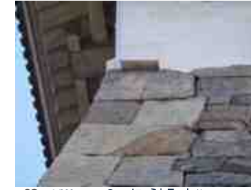
図03 U060隅角部の角石に見られる割れ.jpg
