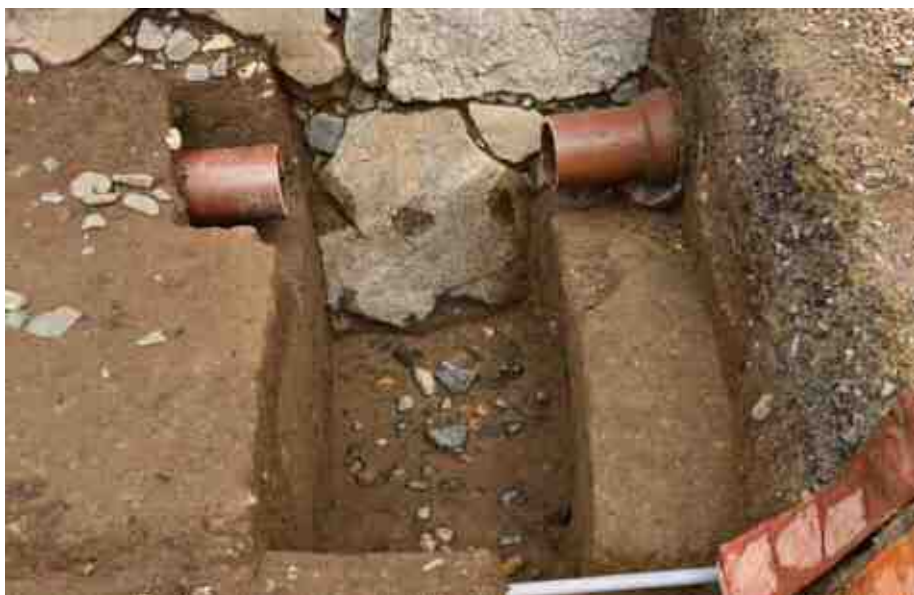
図 15 P区 石垣前面検出状況(南から)
