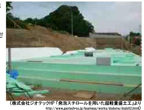
図38 軽量盛土工の施工例
