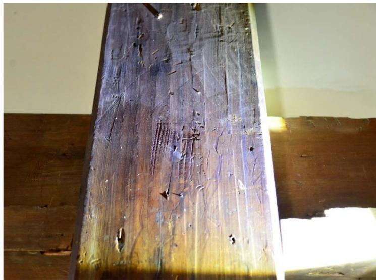
細幅の台鉋で仕上げられた柱(部分的に鉾の加工痕跡有り)
