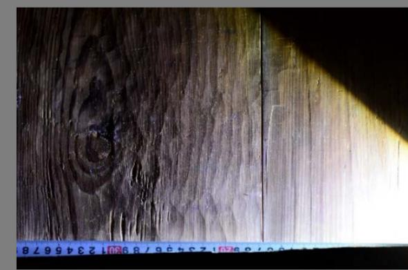
槍鉋による仕上げ(一部、細幅の台鉋仕上げ)
