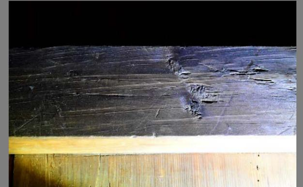
細幅の台鉋による仕上げ(二階貫(階段踊り場))
