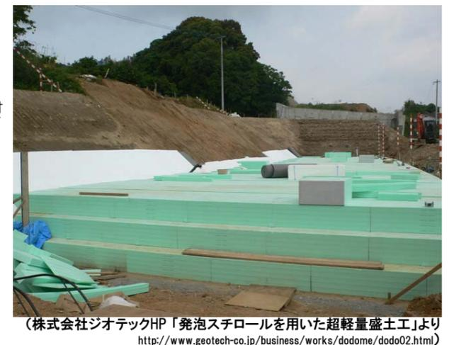
(株式会社ジオテックHP「発泡スチロールを用いた超軽量盛土工」より <http://www.geotech-co.jp/business/works/dodome/dodo02.html>)
