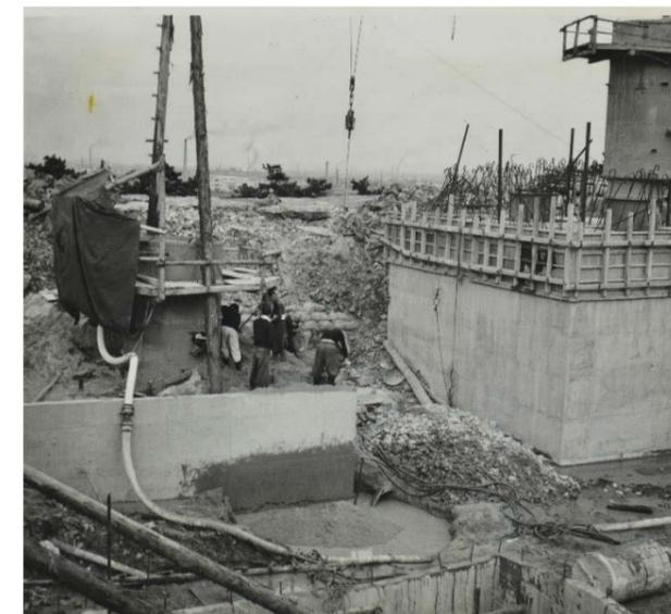
1号ケーソン(西北)沈下の際、ウォータージェットによって東南角に陥没を生じる
