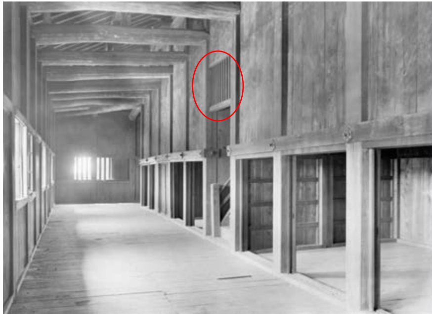
小天守一階～二階の階段の格子窓 「ガラス乾板写真 小天守閣内一階(焼失)南入側」を加工
