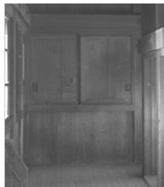
【図1】 5階北面の西側引戸。左側の戸は引手もあるが、実際には固定されている。「ガラス乾板写真天守閣(焼失)西北面」を加工
