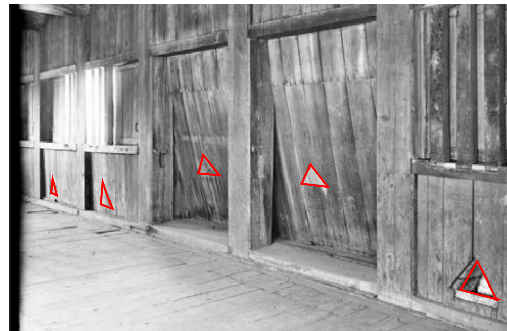
ガラス乾板写真「天守閣一階内橋台上南側の石落及び鉄砲(焼失)」を加工
