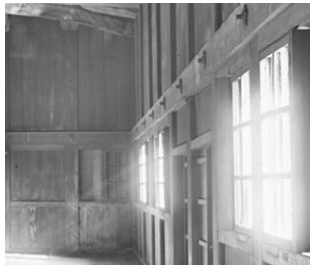
土戸の内側に建具がある。 「ガラス乾板写真 天守閣三階内南入側(焼失)東側」を加工
