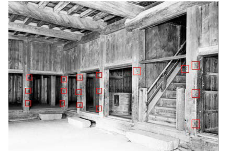
写真で肘金金物が確認できる。 「ガラス乾板写真 小天守閣内地階(焼失)東南側」を加工
