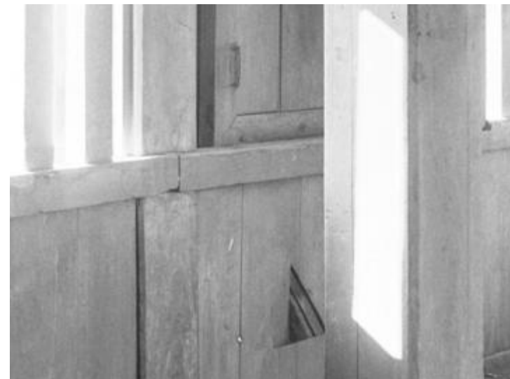
窓敷居の土戸内側部に溝はないように見える。 「ガラス乾板写真 天守閣二階内西入側(焼失)」を加工
