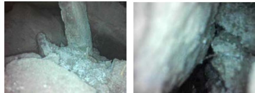
図15 モルタル分類基準 注入状 ガラ溜り
