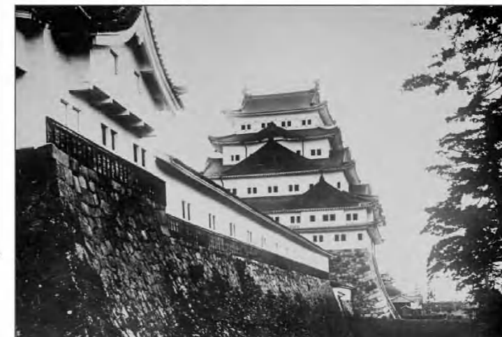
ガラス乾板写真 本丸北面 東北隅櫓（手前、焼失）、糺多間櫓（中央、濃尾地震で被害⇒除却）、大天守（奥） （明治初期 名古屋城総合事務所所蔵）
