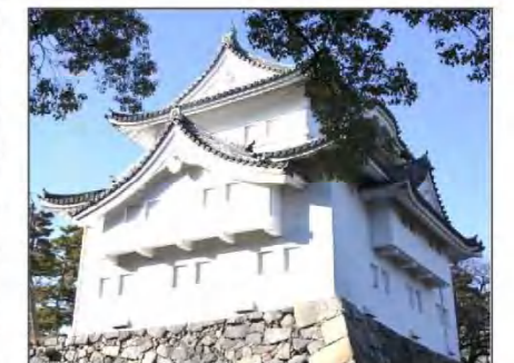
東南隅櫓（重要文化財）
