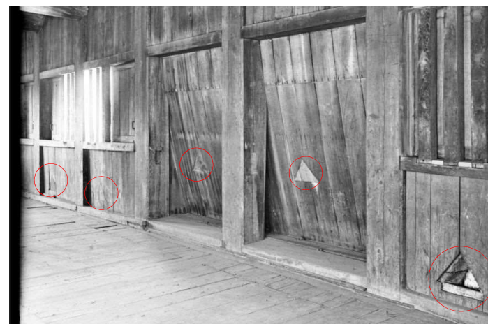
写-6.2.18 名古屋城総合事務所所蔵ガラス乾板写真 「天守閣一階内橋台上南側の石落及び鉄砲(焼失)」 右端部の狭間は蓋が外れており、外壁下地を確認できる
