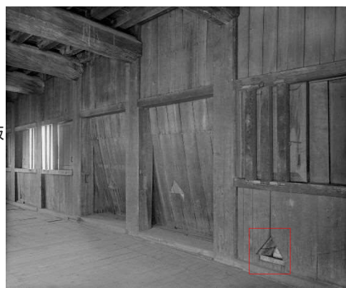
写-6.2.17 ガラス乾板写真「天守閣一階内橋台上南側の石落及び鉄砲狭間」
