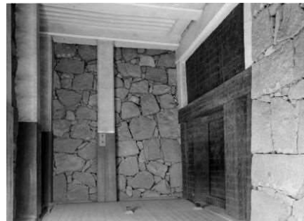
写-6.2.26 ガラス乾板「天守閣地階入口内側・地階枅形の天井全面、柱、梁・奥御門冠木上の柱・梁(枅形側)」
