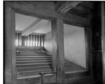
写-6.2.24 ガラス乾板「天守閣地階内東側窓・明り取り窓(北東)の壁・天井」
