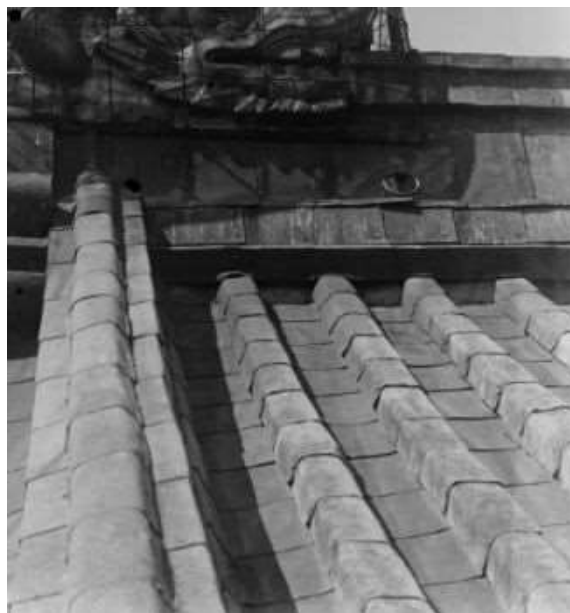
写-6.2.2 ガラス乾板写真「金鯨(南法)(焼失)②」(部分) ・5重の銅瓦葺
