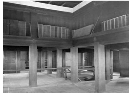
写-6.2.23 ガラス乾板写真「天守閣五階内長押上・五階各部屋の蟻壁」
