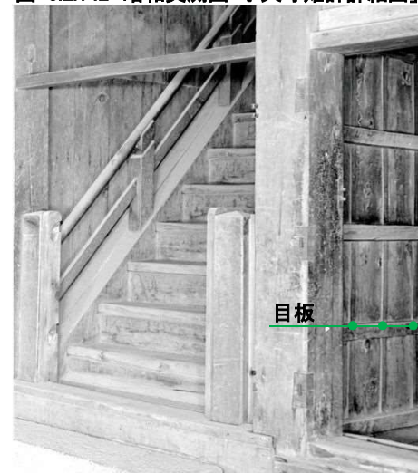
写-6.2.146 「小天守閣内地階(焼失)東南側」(部分) 地階から1階への階段の西側壁が片側豎羽目板壁で、目板があることがわかる
