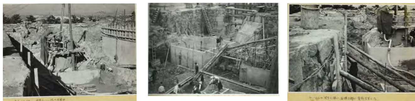
大天守の桁形の石垣をはずし、ケーソンを施工している
