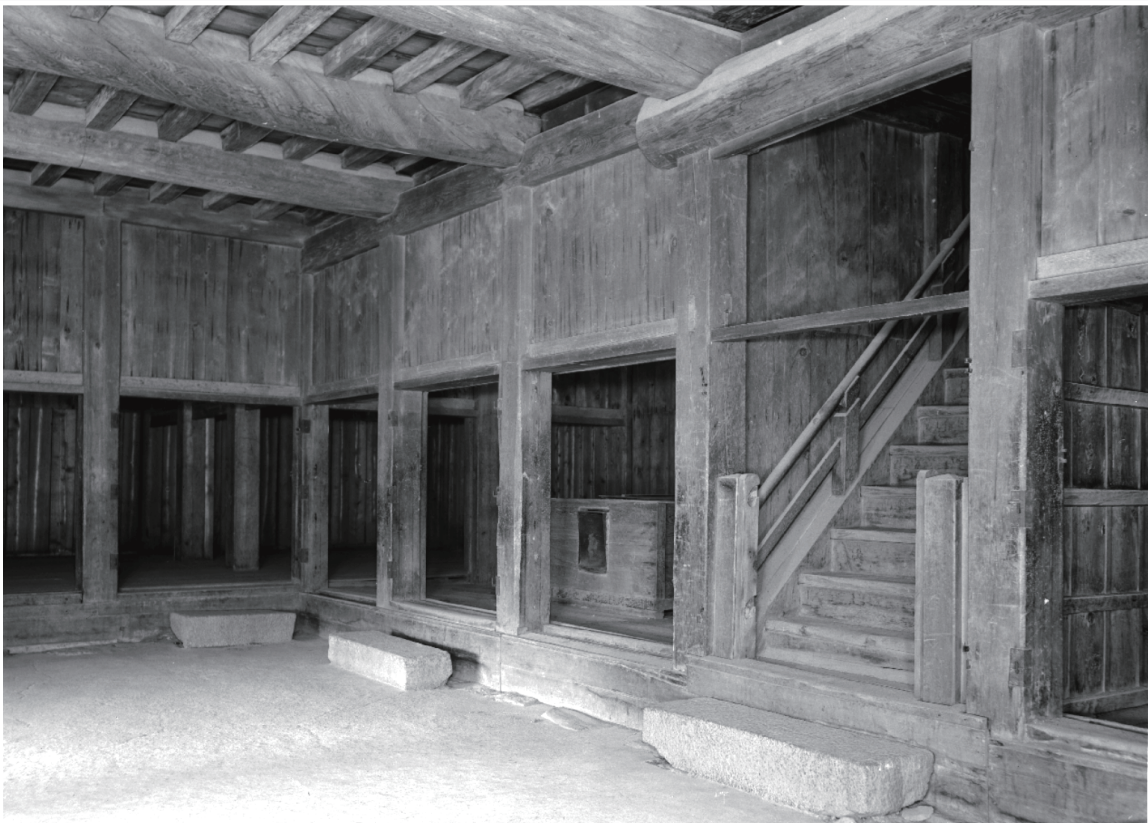
「ガラス乾板写真 小天守内地階(焼失)東南側」
