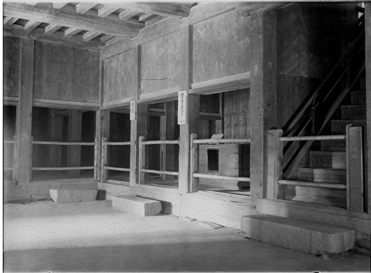
033 57-36-2 小天守閣内地階(焼失)南東側
