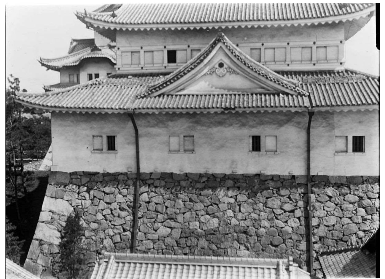
024 50-36-5 小天守閣(焼失)南面
