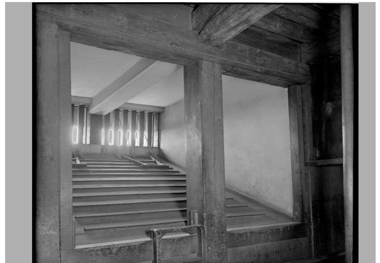
056 78-17-19 天守閣地階内東側窓(焼失)
