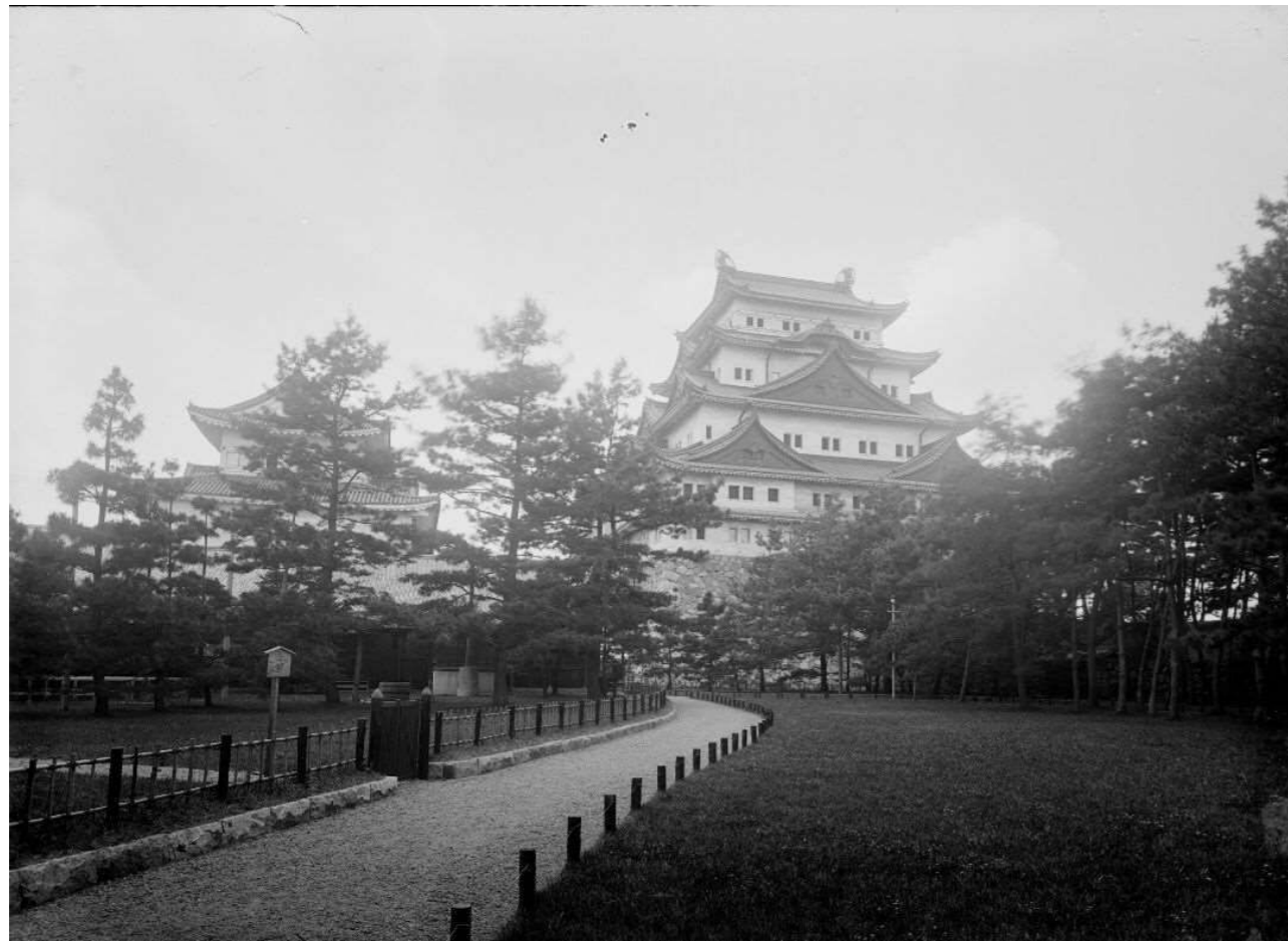
013 40-36-1 本丸地内天守閣(焼失)への通路 天守東面
