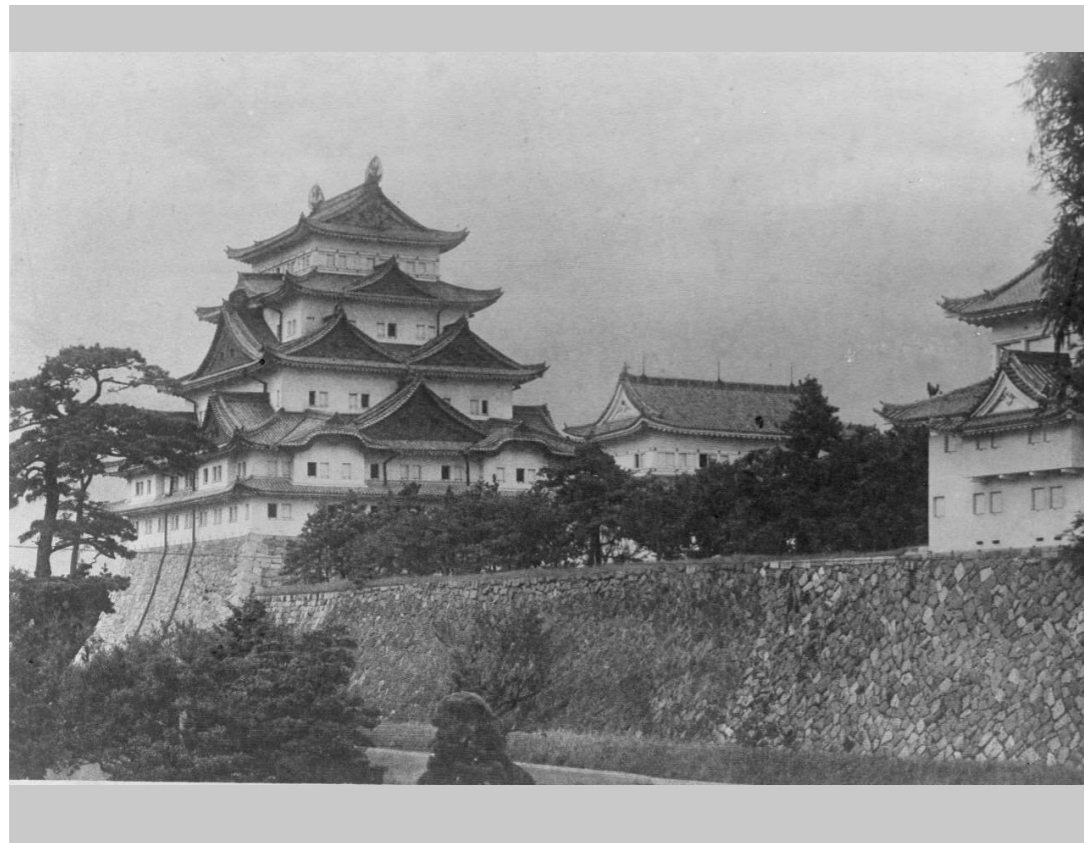
002 15-31-8 本丸郭内遠景(南西面)
