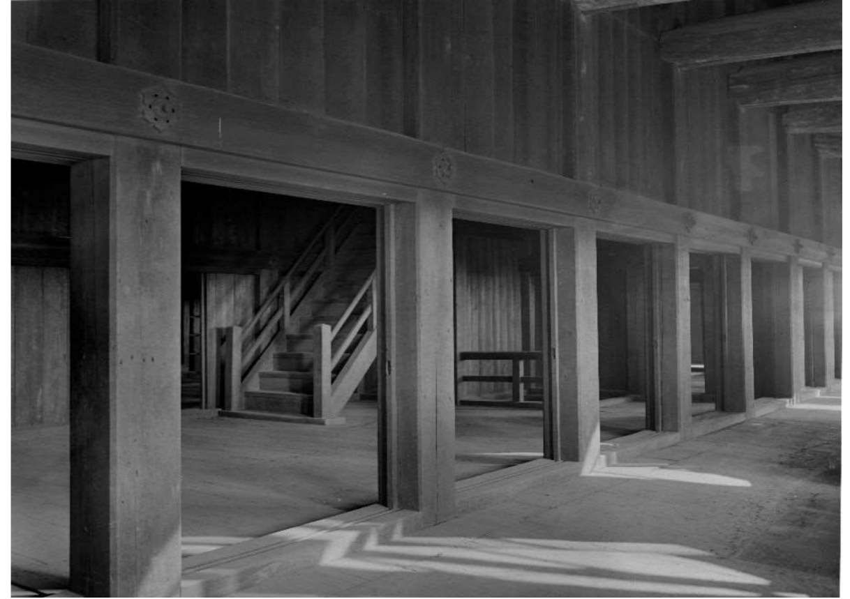
071 82-19-5 天守閣二階内西入側より階段を望む(焼失)
