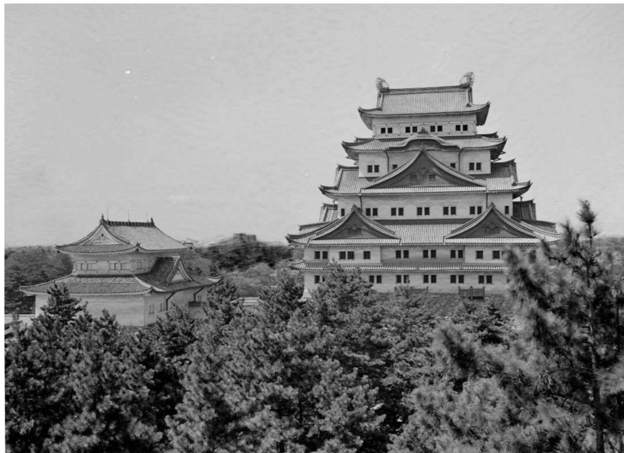
014 42-18-9 大小天守閣(焼失)東面
