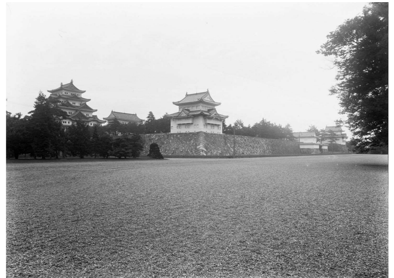
008 15-33-13 本丸郭内遠景(南西面)
