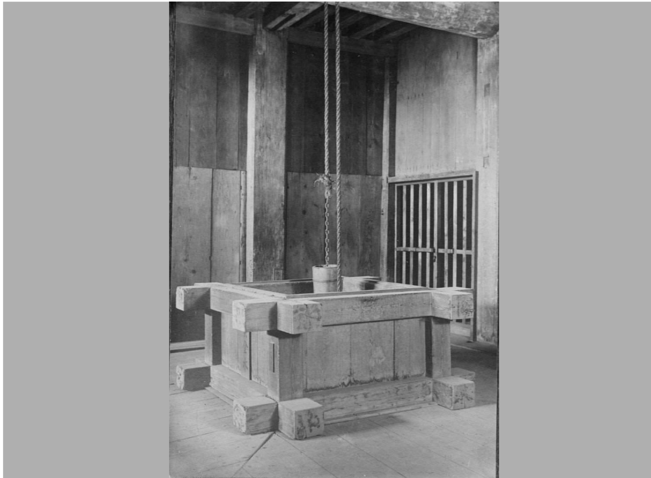
058 79-35-19 天守閣地階内井戸(焼失)
