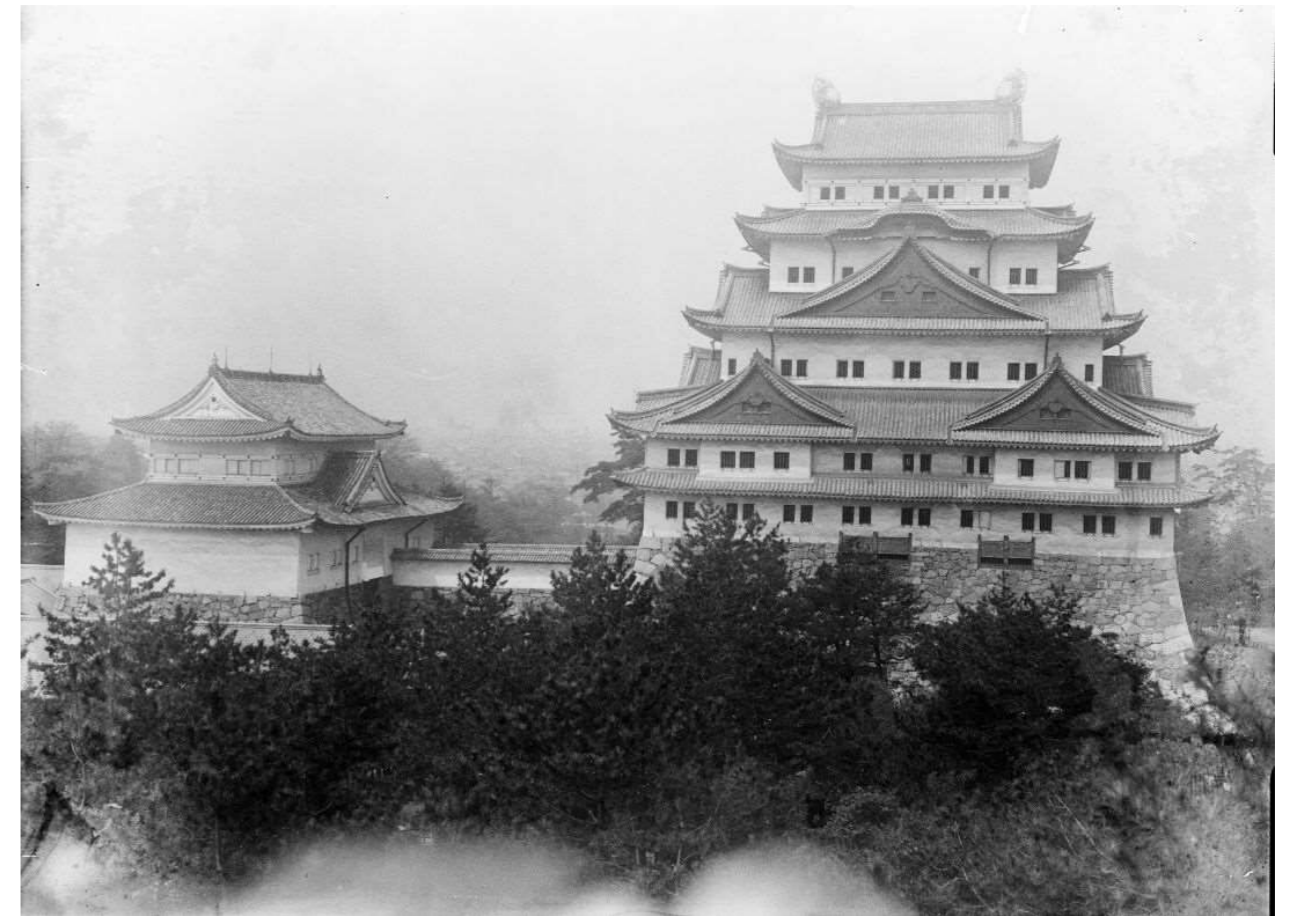
015 42-36-6 大小天守閣(焼失)東面
