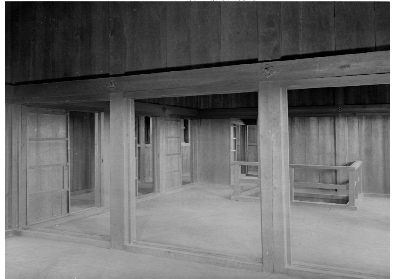
036 59-19-8 小天守閣内二階(焼失)東北側
