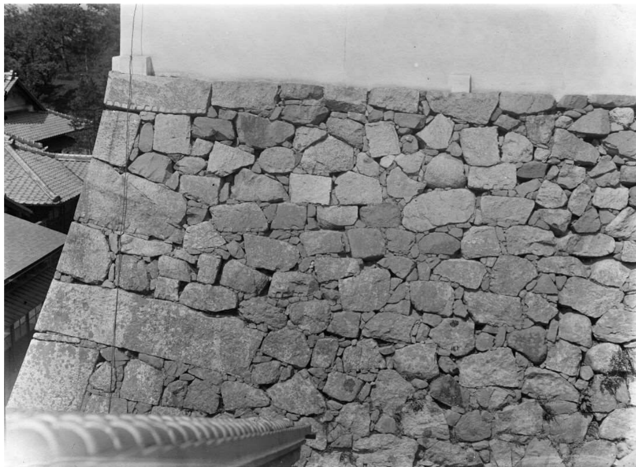
022 49-36-2 小天守閣(焼失)東面石垣
