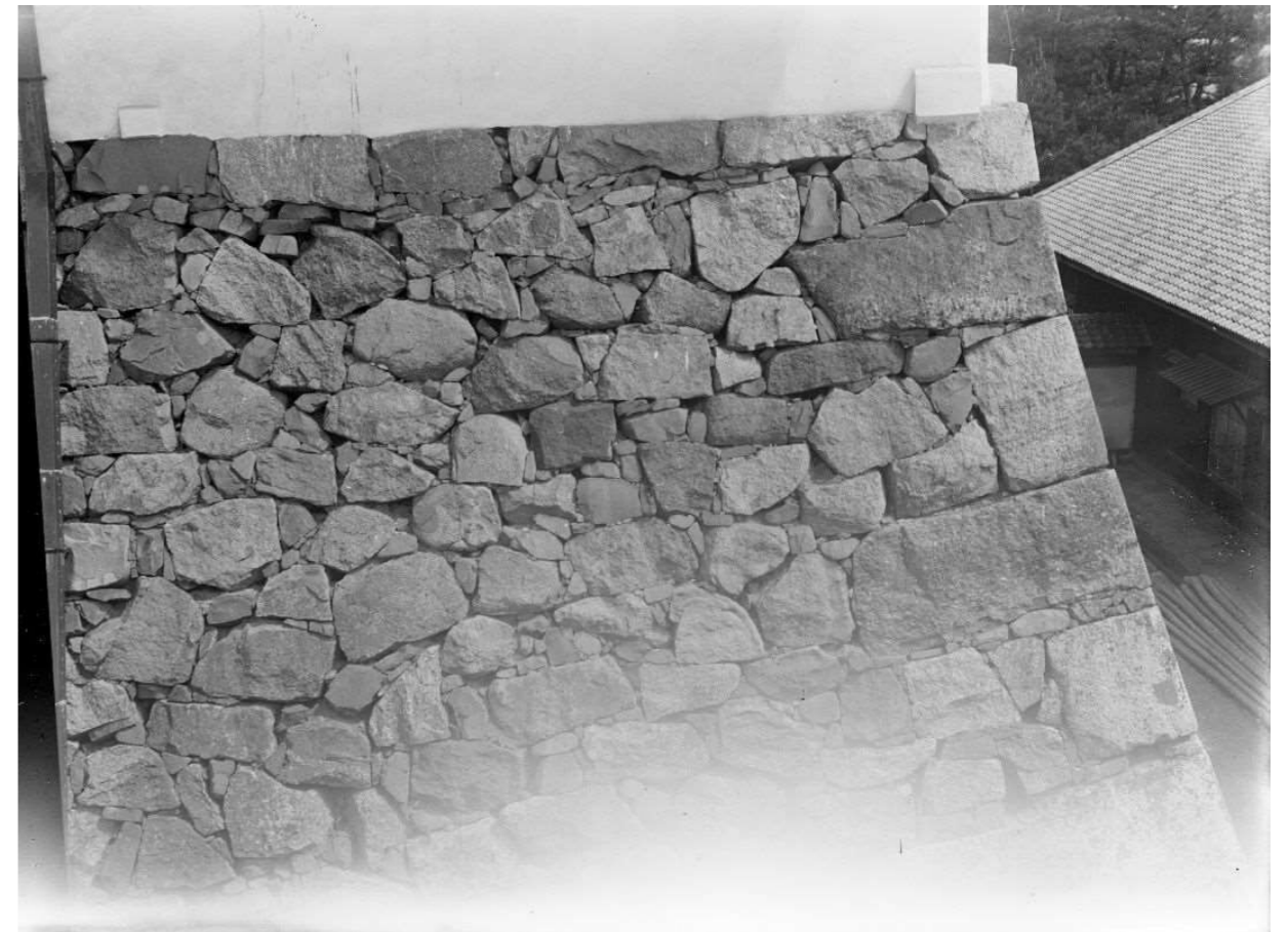
023 51-35-6 小天守閣(焼失)南面石垣
