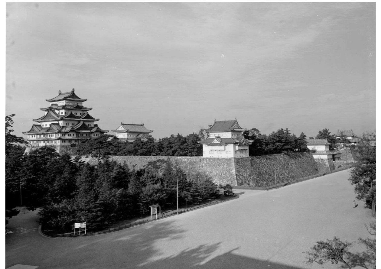
004 15-1-11 本丸郭内遠景(南西面)
