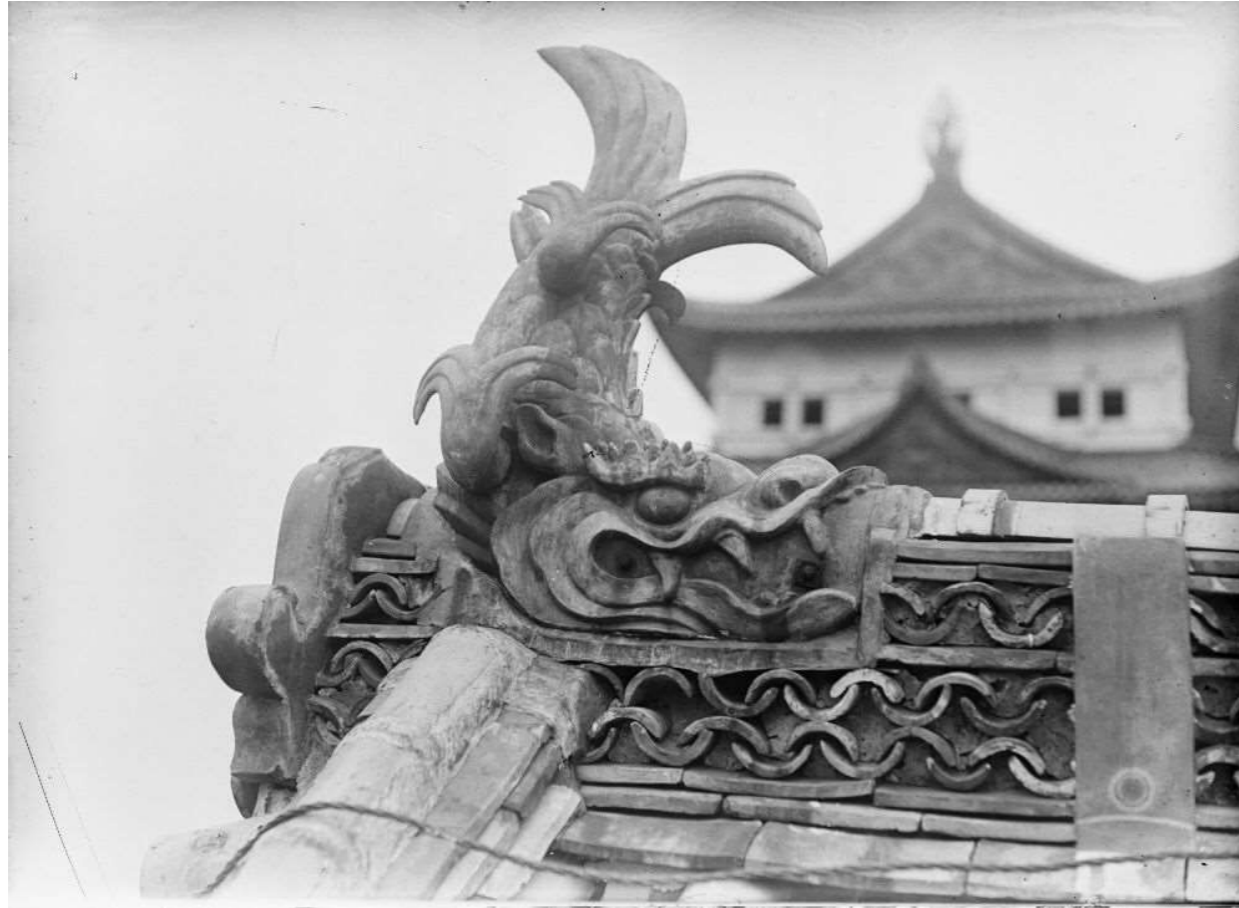
037 61-35-8 小天守閣(焼失)棟上銅鯨(西方)
