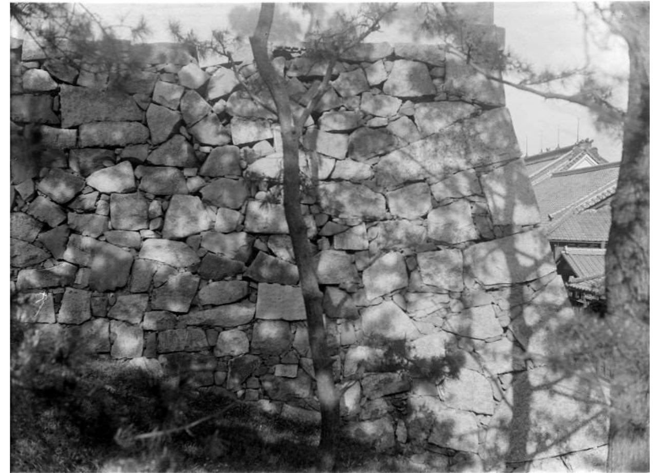
027 53-34-18 小天守閣(焼失)西面石垣
