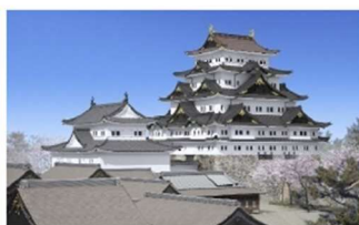
② 5重の銅瓦が酸化した状態
