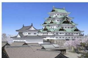
④ 2～5重の銅瓦に緑青が発生した状態
