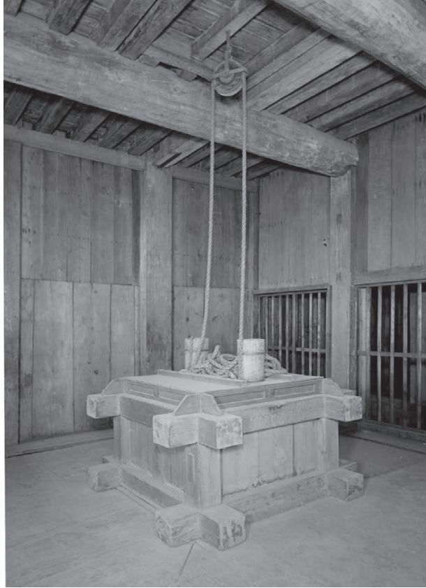
「ガラス乾板写真 名古屋城天守(戦災焼失)地階内部井戸詳細」
