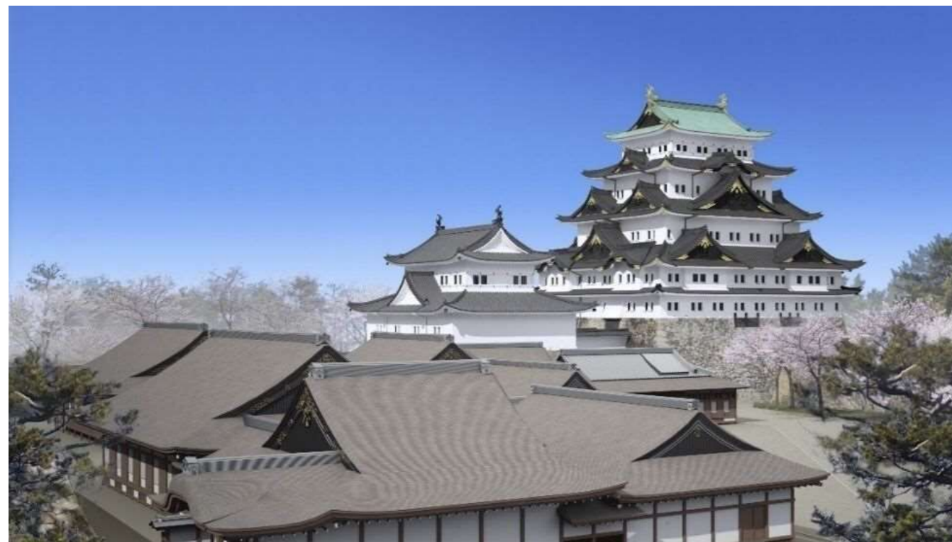
③ 5重の銅瓦に緑青が発生した状態(宝暦大修理後の様子)
