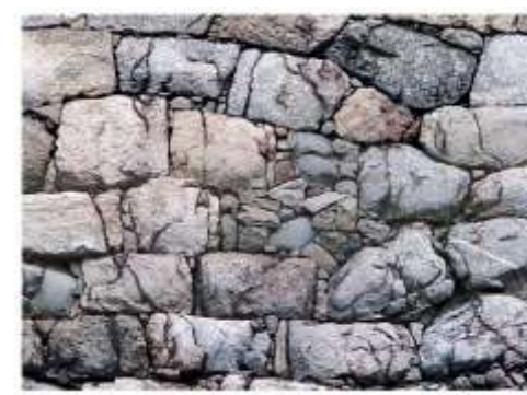
図07 U060_中段_築石粉砕状況.jpg
