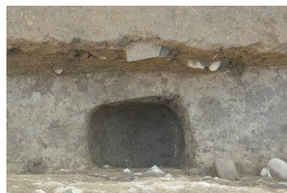
図 21 P01 検出状況（北から）
