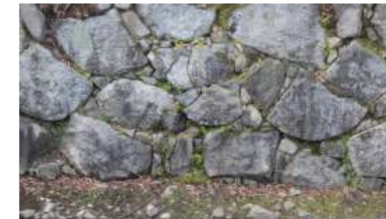
図03 U061_間詰石の状況.jpg
