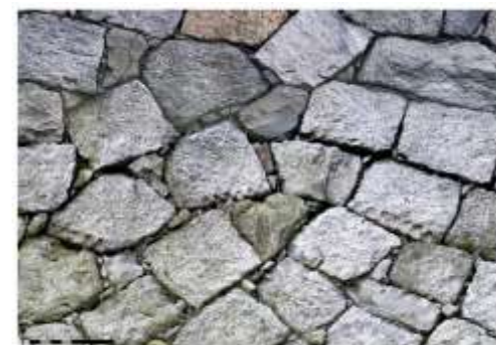
図08 U061_築石部中段_矢穴小.jpg
