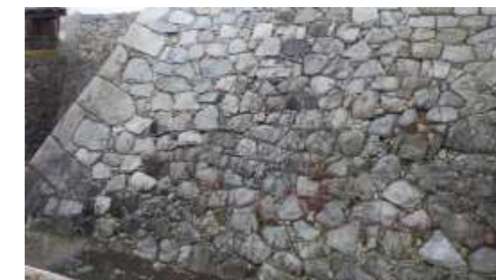
図05 U061_積み出し部_宝暦積み替えライン.jpg
