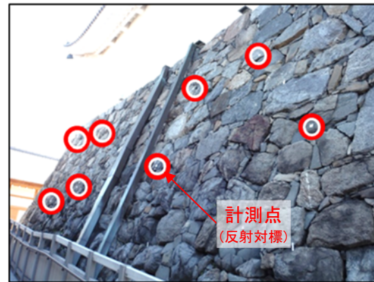
計測点設置状況(小天守東 H136)
