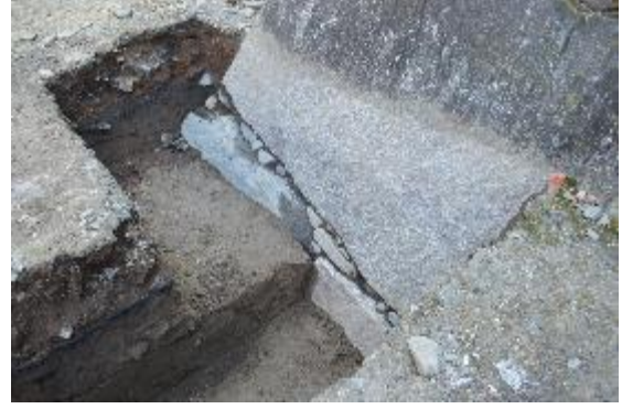
写真 C-2 石垣地下部分状況／北西から
