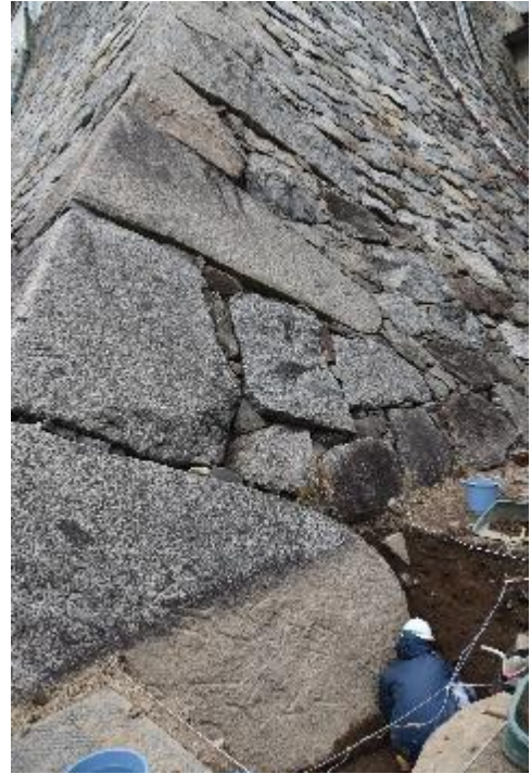
写真 J-1 調査風景／南西から ▶
