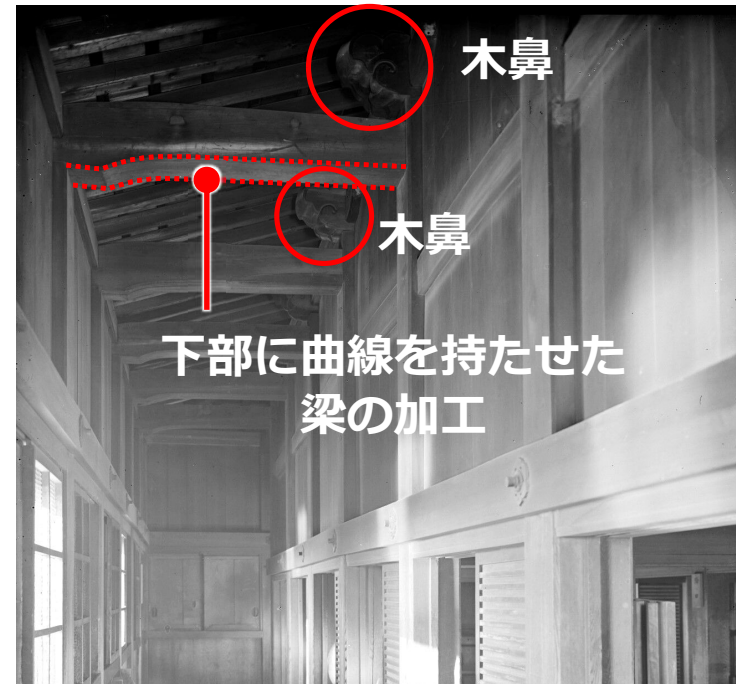
五階入側（ガラス乾板写真）
