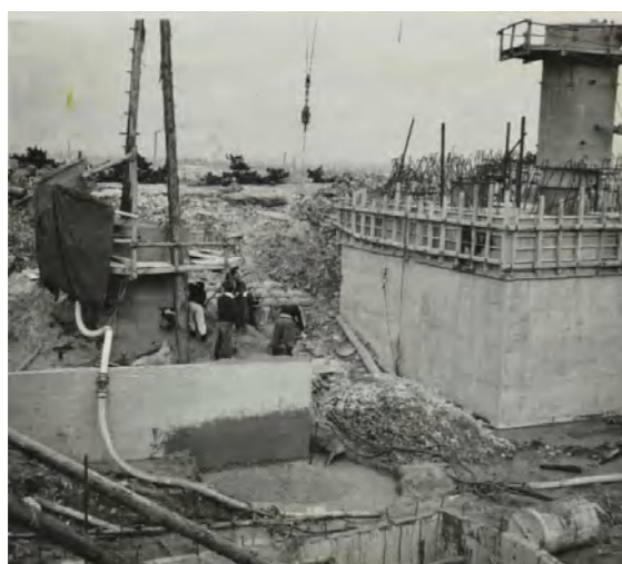
写真(資)-3.4.2 1号ケーソン(西北)沈下の際、ウォーター ジェットによって東南角に陥没を生じる
