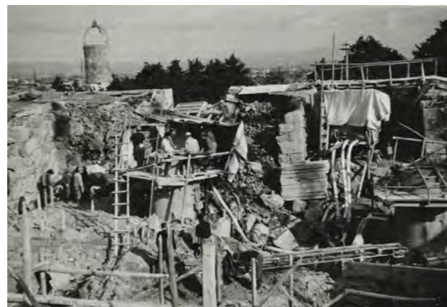
写真(資)-3.4.3 沈下完了間近の4号ケーソン
