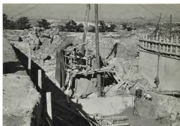
写真(資)-3.4.4 沈下作業中(昭和32年12月20日)
