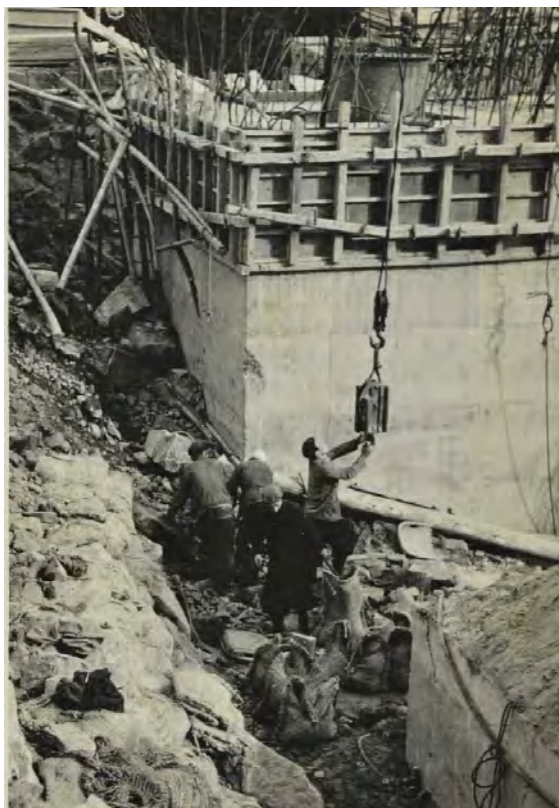
写真(資)-3.4.1 大天守北東角2号ケーソン施工状況
