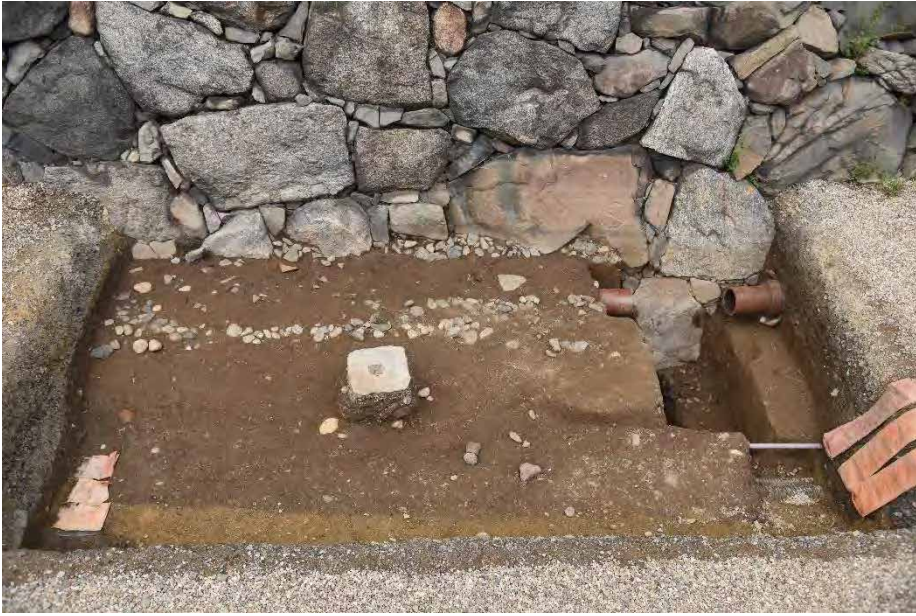
図 13 P区 現況(南から)
