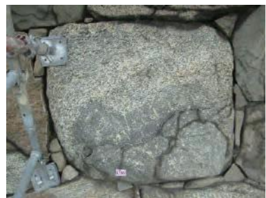
石材調査状況
