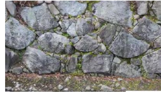
図03 U061_間詰め石の状況.jpg
