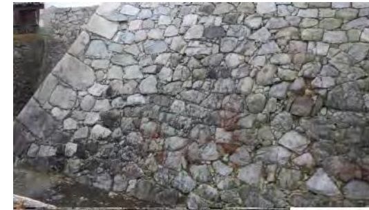
図05 U061_孕み出し部_宝暦積み替えライン.jpg
