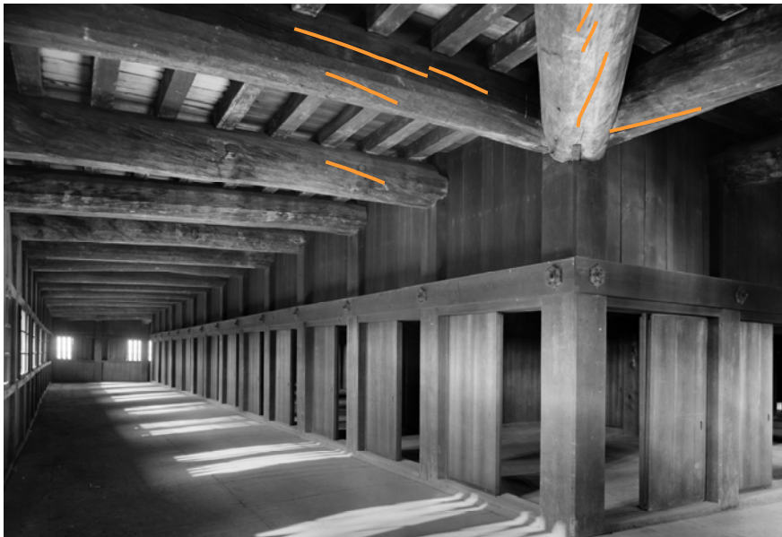
ガラス乾板写真 大天守一階西入側
