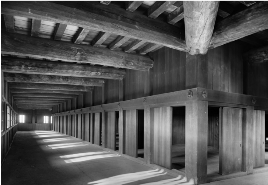
ガラス乾板写真 大天守一階西入側
