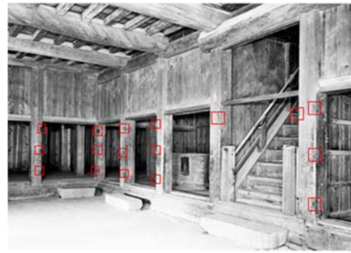
写真で肘金金物が確認できる。 「ガラス乾板写真 小天守閣内地階(焼失)東南側」を加工
