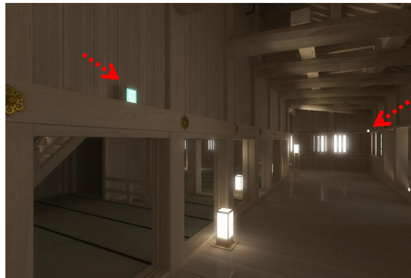
II 西入側(誘導灯)
