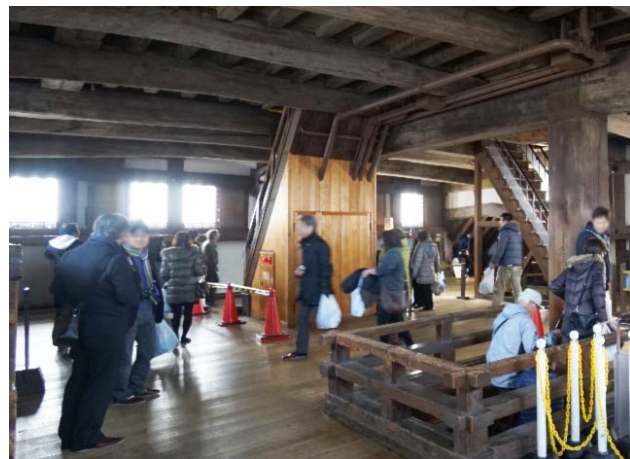
階段下に設置されたアラーム弁室、天井近くを通る主要配管 (写真：竹中工務店撮影)
