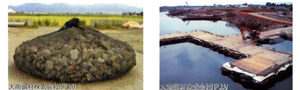
図2-3-9 ボトルユニット(単体)とボトルユニットによる埋め立て構台の例
