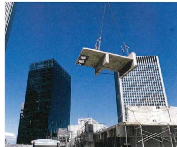
ワイヤーソーによるブロック解体揚重作業例
