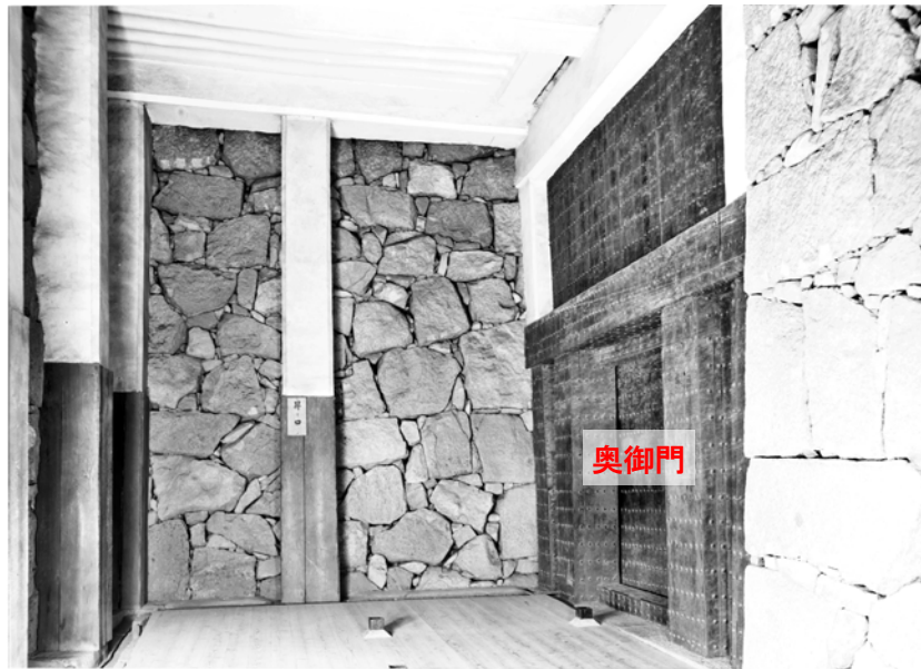
奥御門を通った後の外周壁はすべて縦板張り。 「ガラス乾板写真 天守閣地階入口(焼失)内側」を加工
