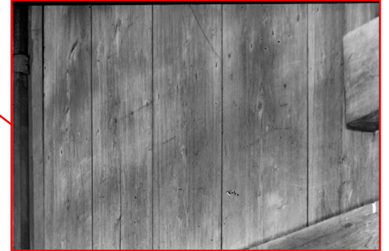
外周内法壁には釘跡が見える。 「ガラス乾板写真 天守閣四階内西側千鳥破風室内入口(焼失)」を加工
