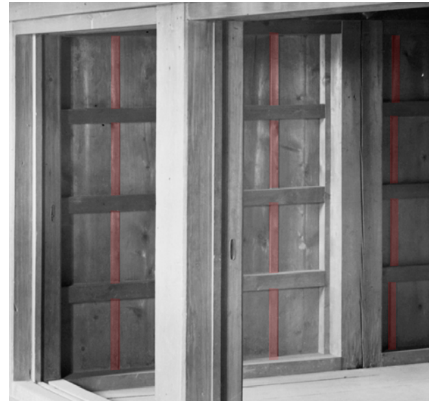
小天守の内法長押より下には目板がある。
