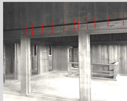
「小天守内二階(焼失)東北側」を加工
