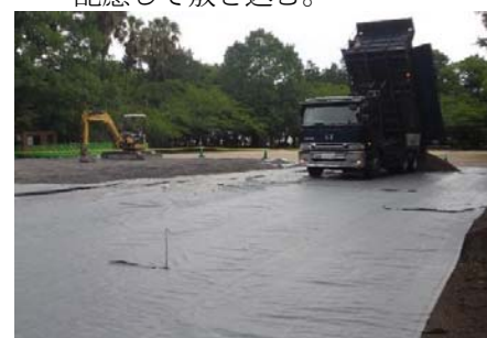
平成30年6月 特別史跡名古屋城跡の現状変更「石垣調査のための仮設事務所等工事」より 図2-3-2 土木シート敷設と碎石敷均し状況の例
