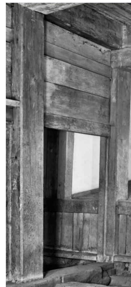
内法貫と飛貫の間に横厚板が2枚見える。 「ガラス乾板写真 天守閣地階内南側窓(焼失)」を加工
