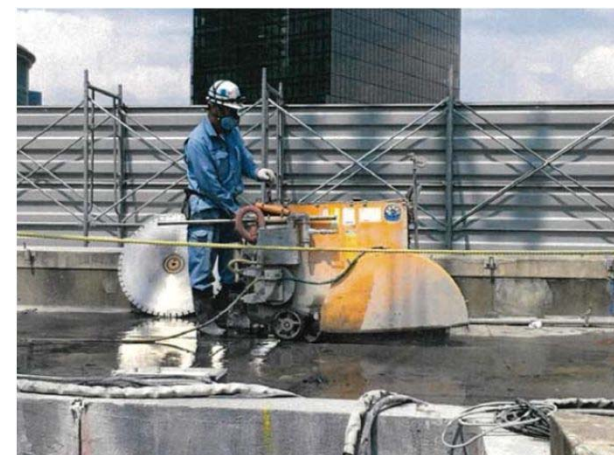
ウォールソーによる切断状況例
