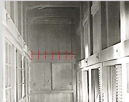
「天守閣五階内入側(焼失)」を加工
