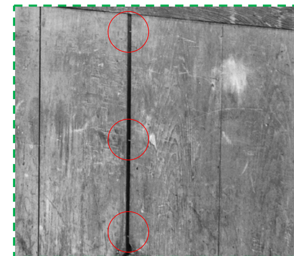
〇部に合釘が見える。 「ガラス乾板写真 天守閣一階内橋台上南側の石落及び鉄砲(焼失)」を加工
