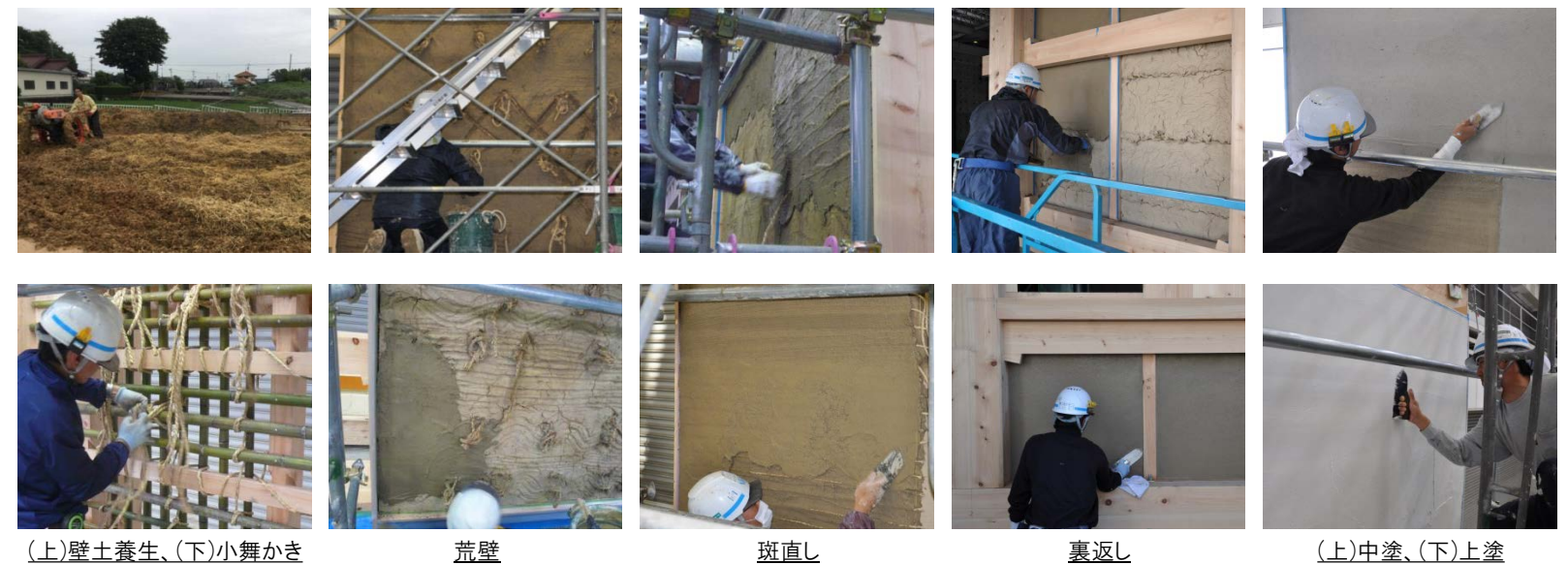
試験体および実験状況
