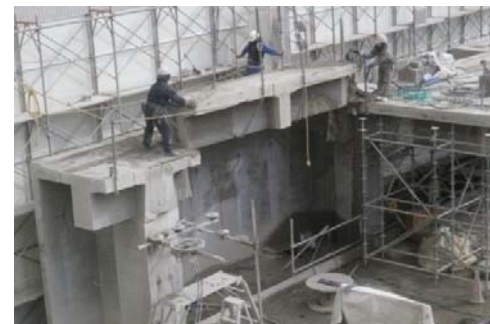
ワイヤーソーによるブロック解体場重作業例
