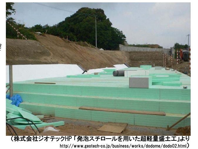
図2-2-15 軽量盛土工の施工例
