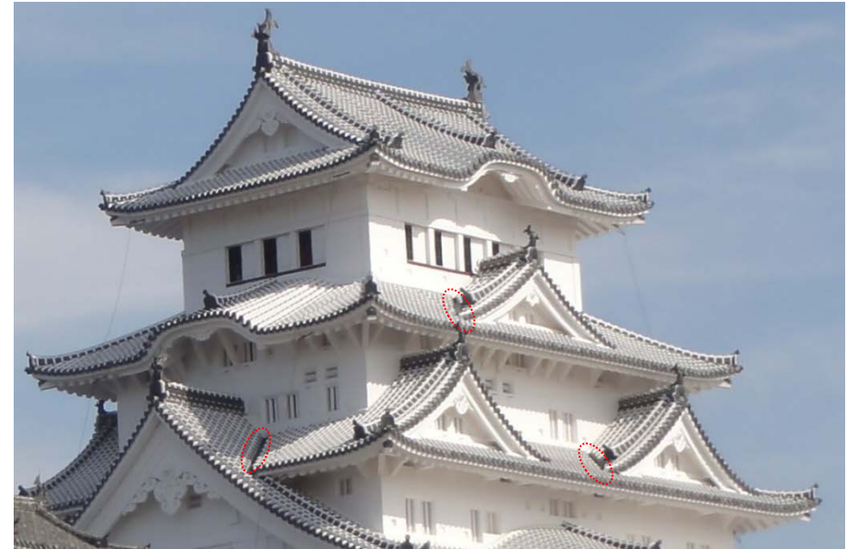
各重屋根と破風部の取合い谷樋
