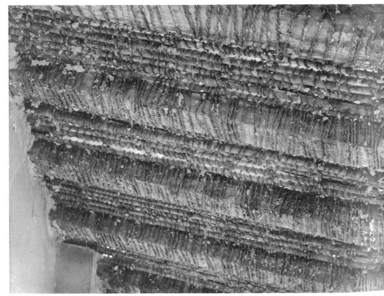
第七七回 解体中壁下地（其の三）（揚げ塗下地）
