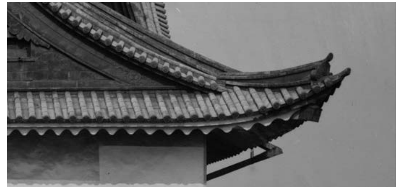
南面 ガラス乾板写真「天守閣(焼失)南面」を加工 三層部分
