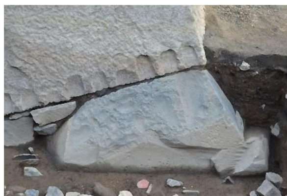
写真F-3 石垣地下部分状況／北から 角石の上半を、旧堀底（戦前）に合わせて加工している様子。
