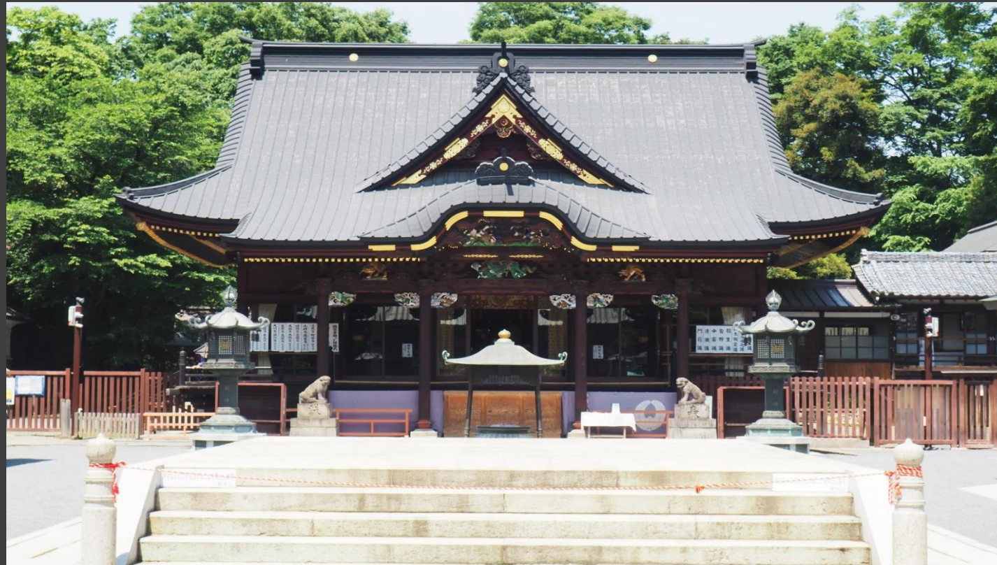
銅瓦屋根でのチャン塗の事例、経年変化(約6年半)について:妻沼聖天山歓喜院:保存修理工事H23(2011年)(H24 国宝指定)
