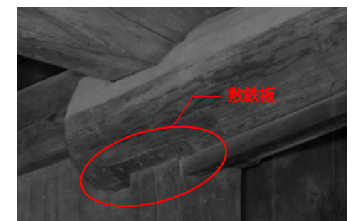
敷鉄板が写っている写真（竹中工務店画像加工） ガラス乾板写真(天守閣一階内橋台土南側の石落及び鉄砲狭間) (名古屋城総合事務所所蔵)
