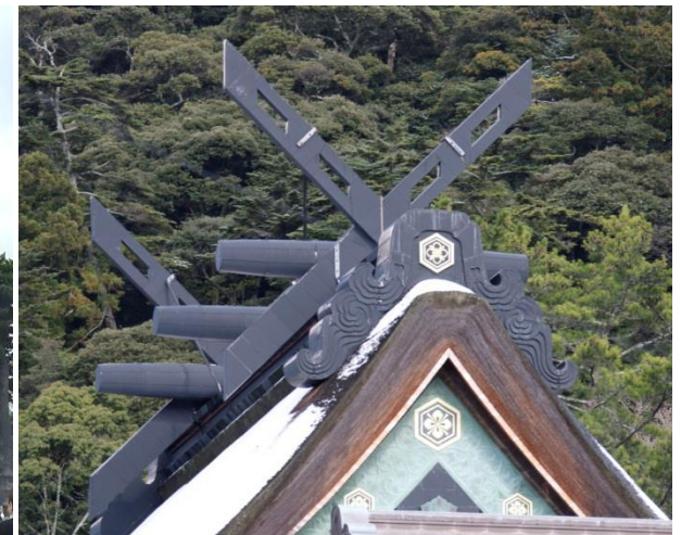
出雲大社御本殿 平成の大遷宮 (※) 箱棟、鬼板、千木、勝男木：銅板下地にチャン塗
