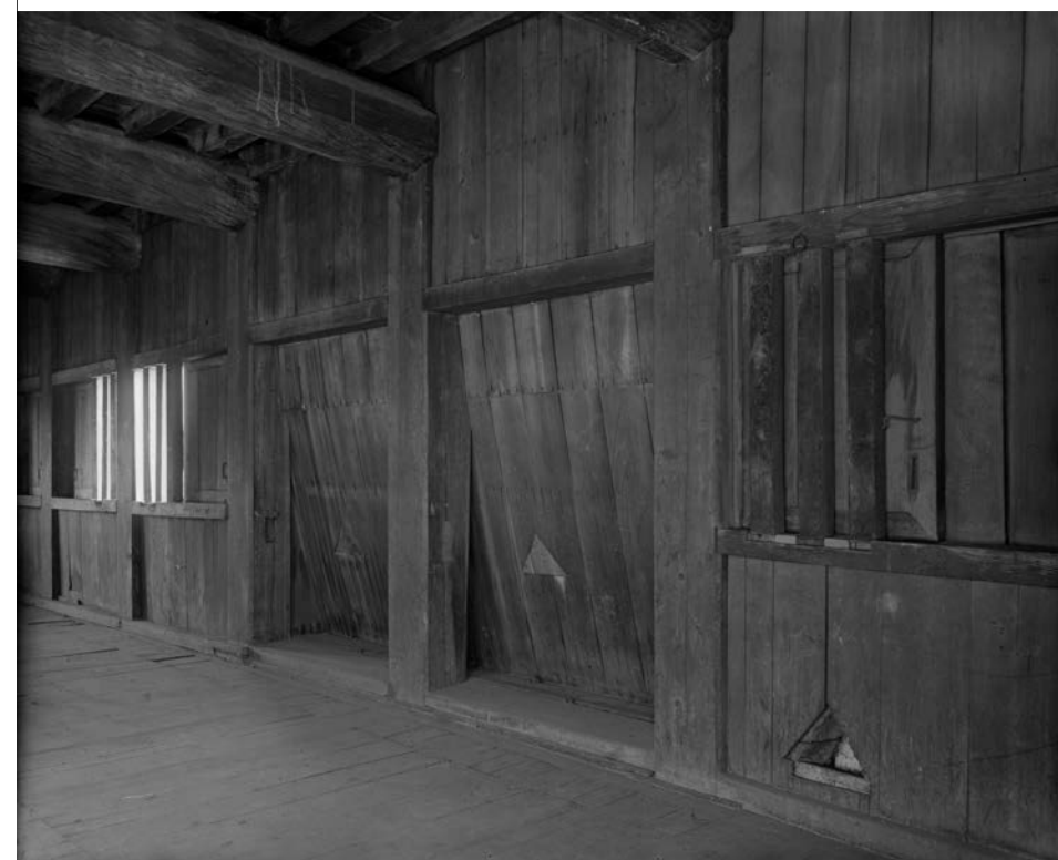
070 80-17-18 天守閣一階内橋台上南側の石落及び鉄砲(焼失)
