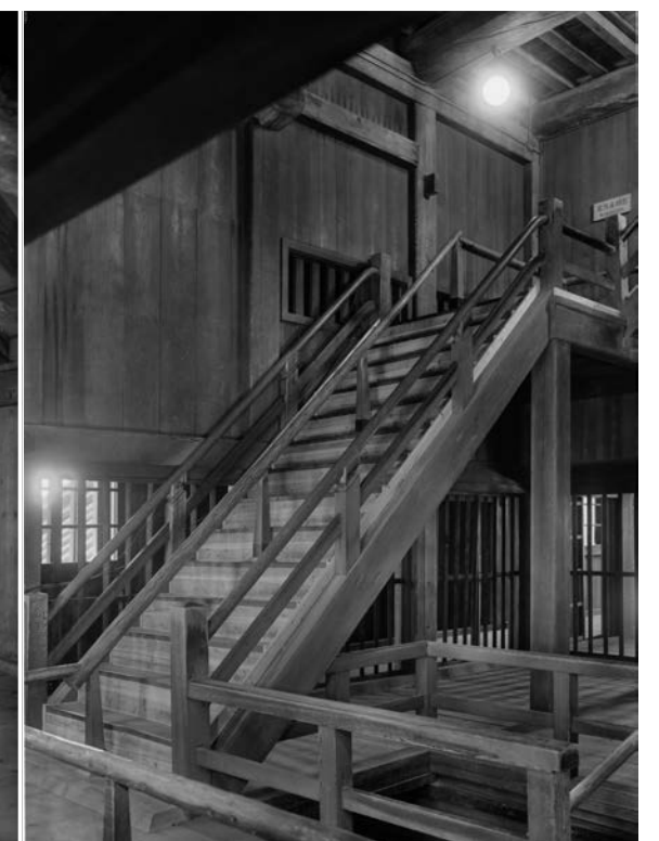
079 88-20-15 天守閣四階内階段(焼失)
