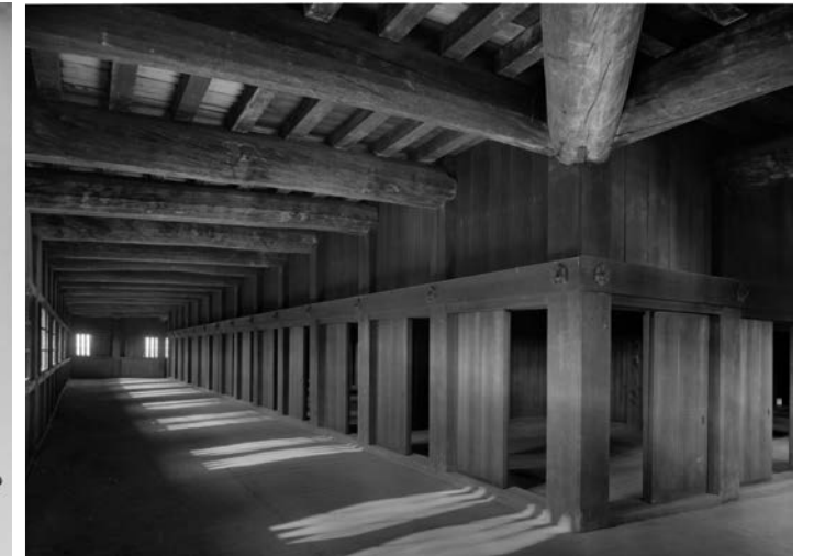
069 81-19-4 天守閣一階内西入側(焼失)
