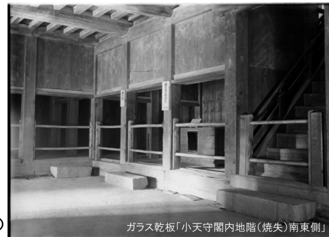
床面以外は木仕上げとなっている。
