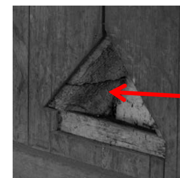
ガラス乾板写真(名古屋城総合事務所 所蔵) 天守閣一階内橋台上南側の石落及び鉄砲狭間
