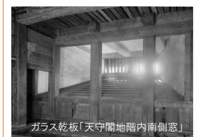
南側明り取り窓の壁・天井
