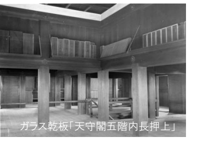
五階各部屋内側の蟻壁天井
