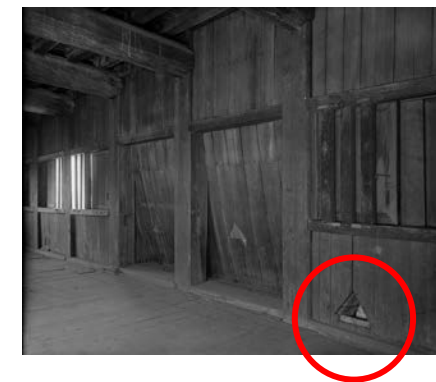
ガラス乾板写真(名古屋城総合事務所 所蔵) 天守閣一階内橋台上南側の石落及び鉄砲狭間
