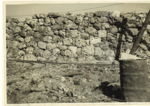
「昭和三十一年三月竣工 名古屋城天守閣跡 石垣積替工事写真帖」 名古屋城管理事務所
