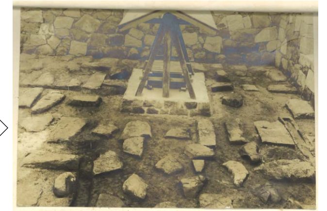
「昭和三十一年三月竣工 名古屋城天守閣跡 石垣積替工事写真帖」 名古屋城管理事務所
