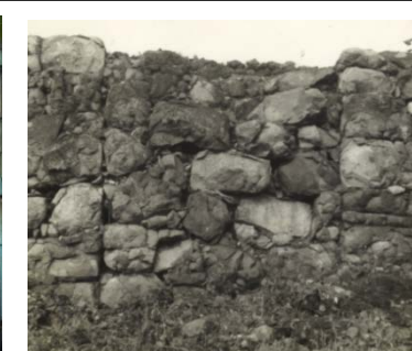
内側 昭和30年度 積換工事前
