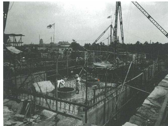
『名古屋城再建』p.27 昭和32年8月11日の記事 「沈下準備の終わった大天守のケーソン」 周囲の穴蔵内側の石垣はまだ崩されていない
