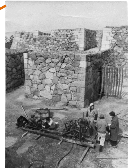
出典：名古屋タイムズアーカイブズ委員会 所蔵 裏面書込310220 写真裏書「土質調 査のボーリング据付け」
