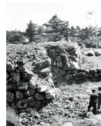
出典：中日新聞 所蔵 「名古屋城の石垣壊れる 崩れかかった 名古屋城本丸石垣」
