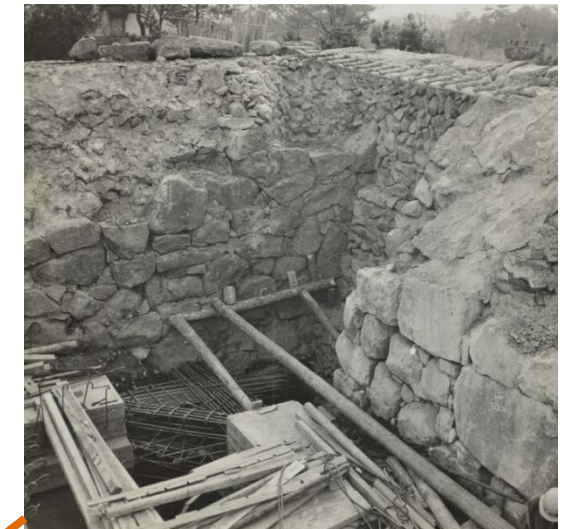
『名古屋城改築工程写真 其一』p.8 「石垣は創建当初この部分を出入口に計画されたとの記録があったが、今回のこの工事でその事実が判明した。西側(前方)の石垣が西(右方)へ延びている」
