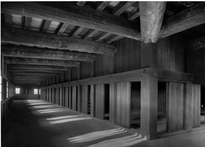
天守閣一階内西入側（焼失）
