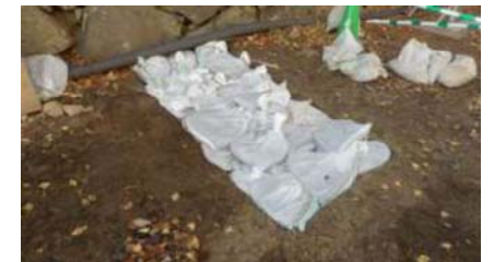
図 4.19 仮埋戻し状況
