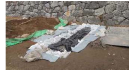
図 4.19 仮埋戻し状況
