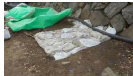
図 4.17 仮埋戻し状況
