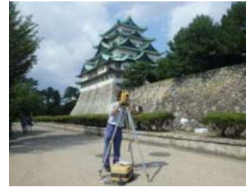
写真 2.1 基準点測量状況
