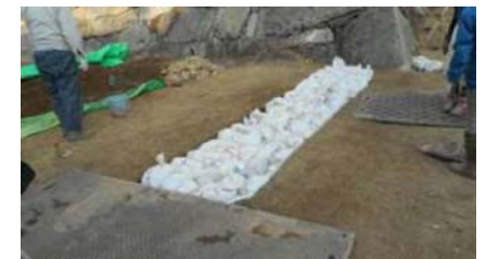
図 4.4 仮埋戻し状況
