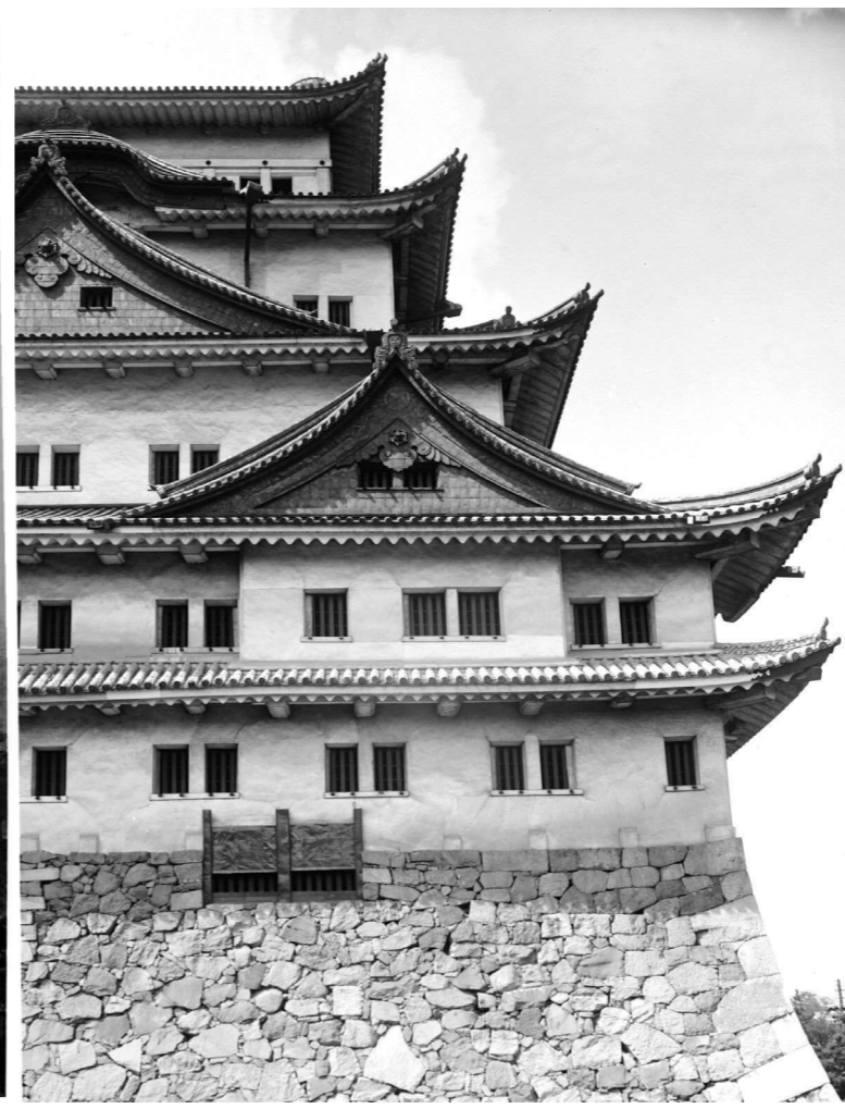
天守閣（焼失）東面北寄部分
