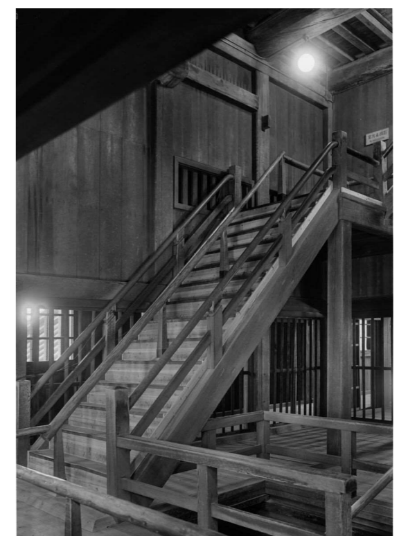
天守閣四階内階段（焼失）
