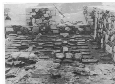
東面明取り方向を望む
