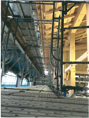
写真-3 外部足場(例)
