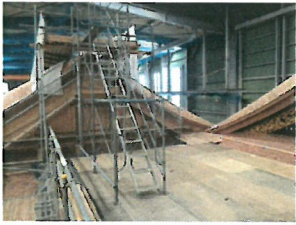
写真-4 破風用足場(例)
