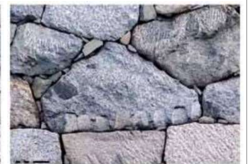
図09 U061_築石部中段_矢穴大.jpg
