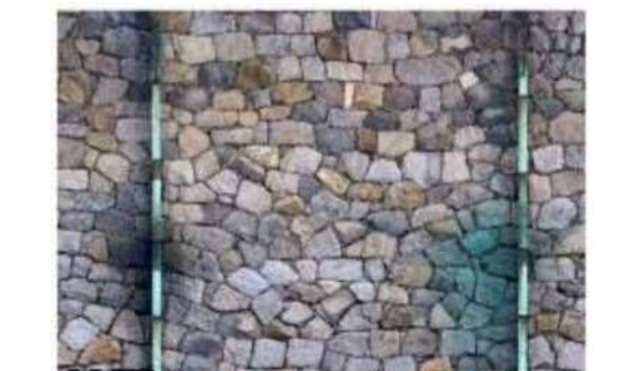
図07 U061_築石部中段_布積崩し.jpg
