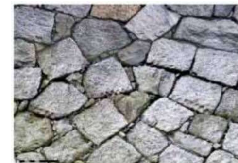
図08 U061_築石部中段_矢穴小.jpg
