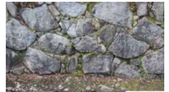
図03 U061_間詰石の状況.jpg
