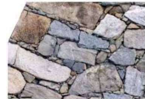
図10 U061_隅角部中段_クリコミ.jpg
