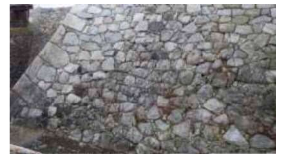
図05 U061_孕み出し部_宝暦積み替えライン.jpg
