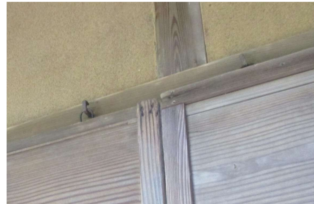
修学院離宮 隣雲亭の中敷居窓の掛雨戸の二重折釘
