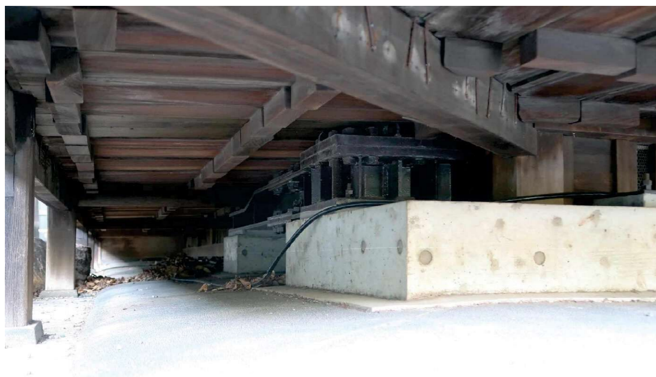
鉄骨補強の基礎部分を見る。
