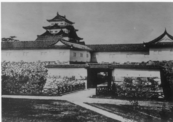
『名古屋城本丸大手口南面』 (明治12年(1879)から同24年(1891)頃) (名古屋城総合事務所蔵 ガラス乾板写真より)
