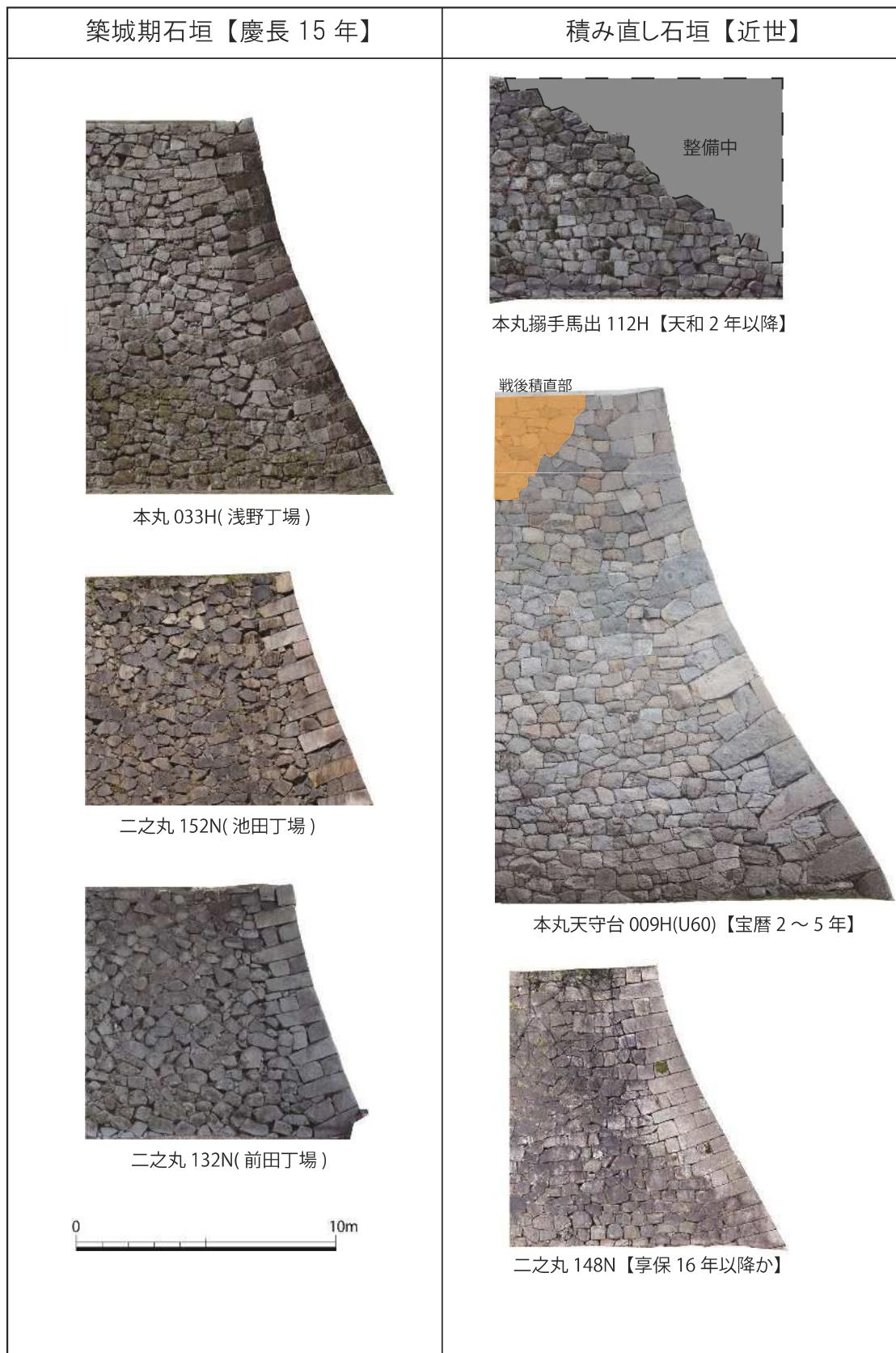
図 3-12 築城期石垣および史料等に積み直しの記載がある石垣の例
