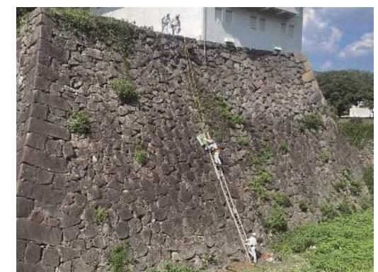
図3 レーダー探査実施状況 (021H)
