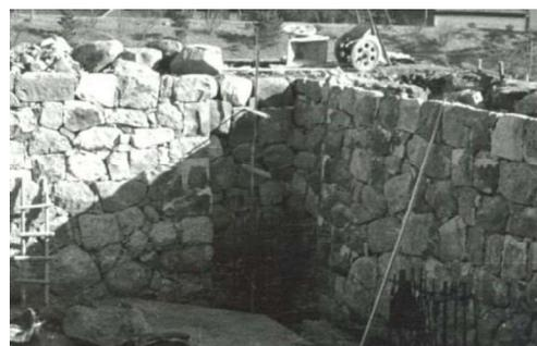
天守閣再建工事中：小天守の柱を設置するために入隅部の石垣を凹ませて積み直し
