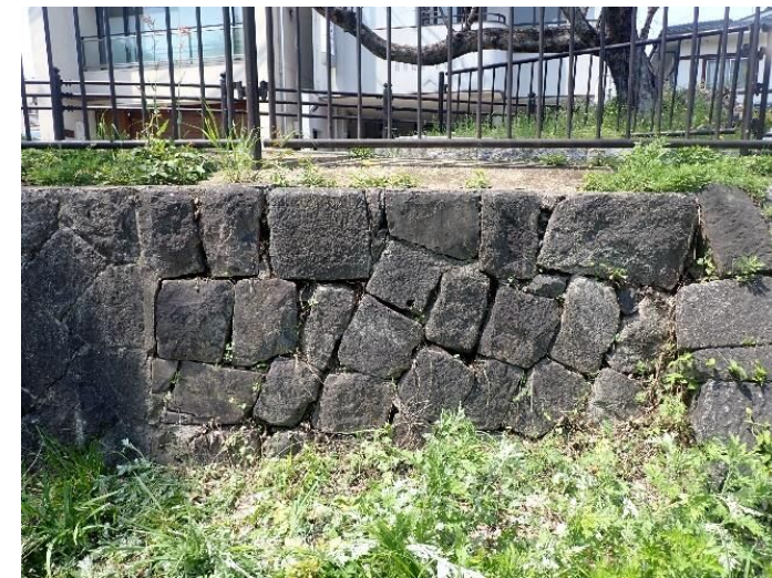
図 9 現存する辰之口南側の石垣
