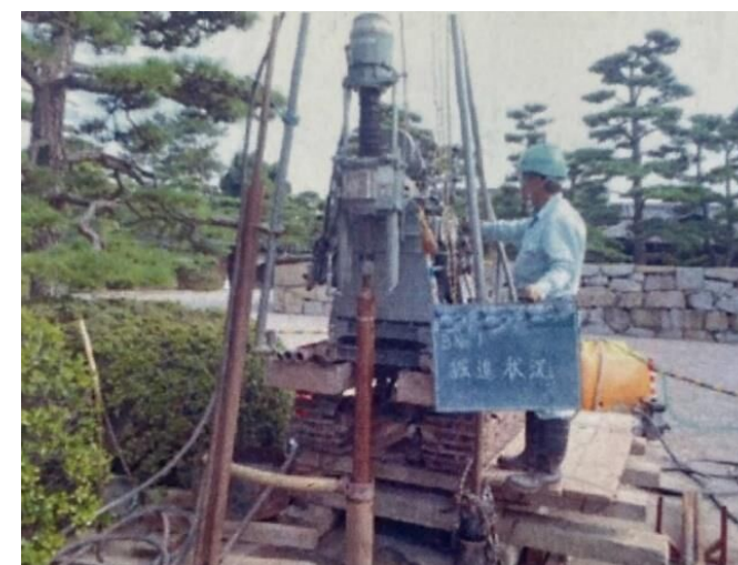
実施例 ボーリング調査状況
