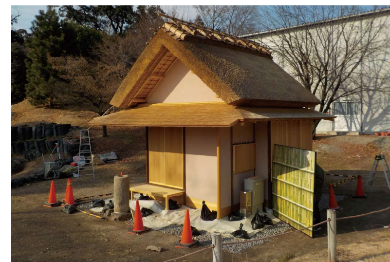
写真2-6 袖垣（東側）実寸模型設置状況（角度45度） （南東側より）
