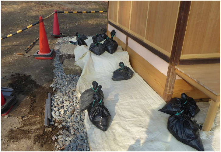
写真 5-1 熨斗瓦設置状況
