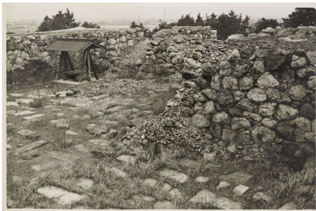
柵形、開口部周りの角に崩壊している部分がある。
