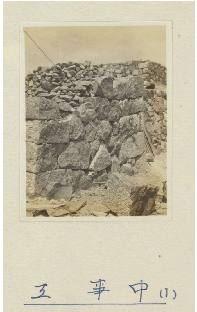
B 小天守SA02 積直し工事中
