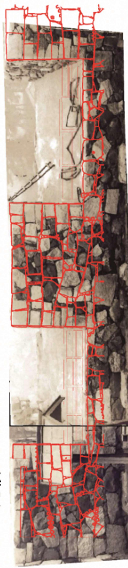
AとCの比較 ④積替工事後_名古屋城天守閣跡石垣積替工事写真帳_027,28 (1956年)
