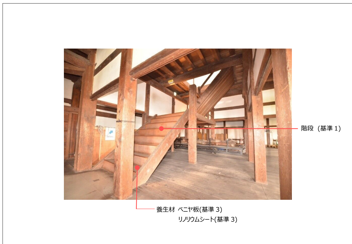
西北隅櫓内部 1 階
