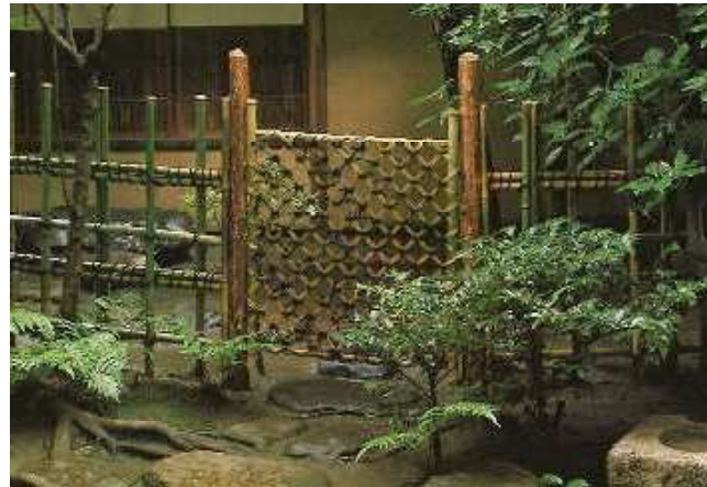
写真 2-1 サビ丸太支柱の例 (金澤邸方圖庵)
