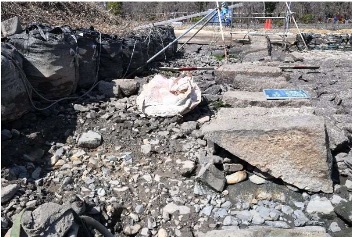
図2 001-2856 栗石状況（築石周辺に細かな円礫が入る）（南から）
