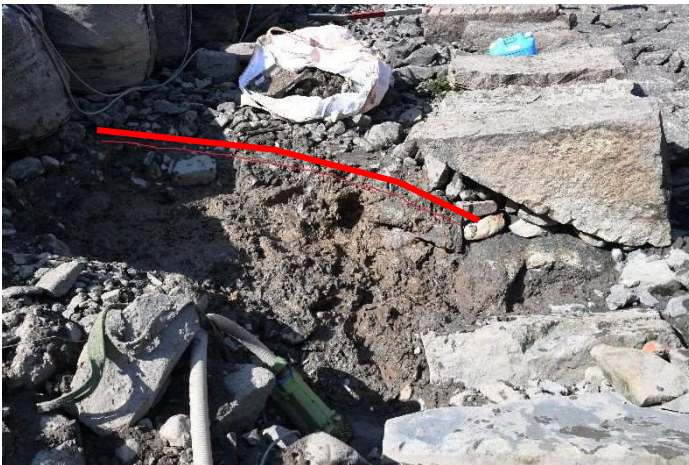
図3 001-2856 背面堆積状況（赤い線より上がへドロ状堆積、下が黄褐色粘質土）（南から）
