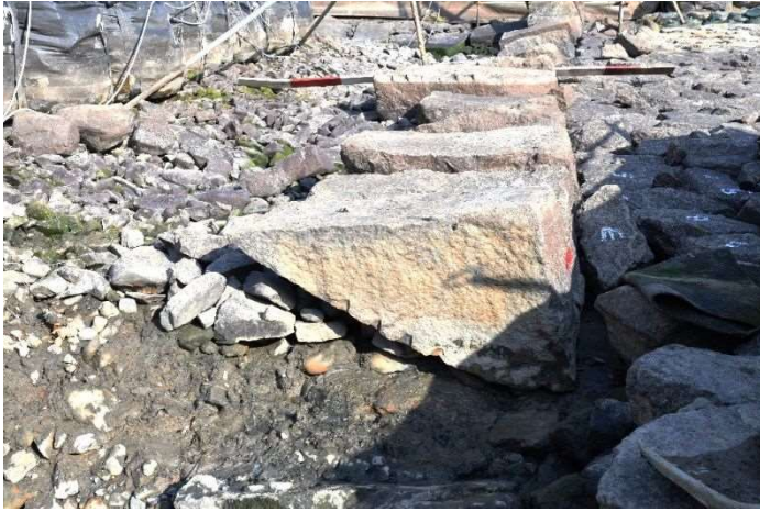
図1 001-2856 解体前（南から）
