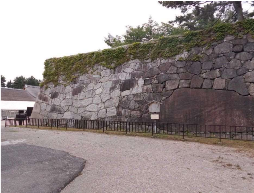
写真1 東一之門跡(西側)石垣(東から)(白っぽく見えるのが新補石材)
