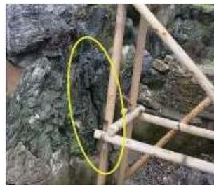
権現山裾石橋南側の橋を支持する石組においては、上部の石橋支持景石から荷重がかかる景石に亀裂が確認される。この景石に樹脂等での接着と意匠復元を行う。
