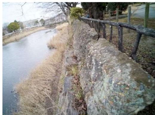
写真 4-3-20 北面/南側に傾倒した状態
