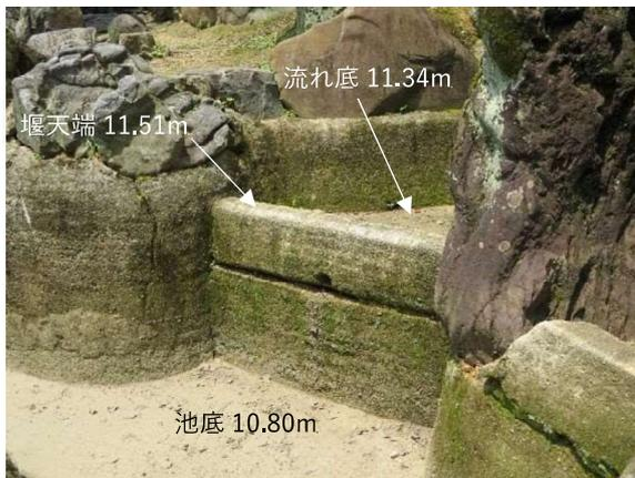
写真 4-3-10 水系設備とみられる護岸構造物
