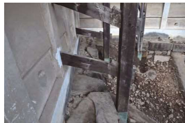
図 15 西側土塀 土塀背面検出状況
